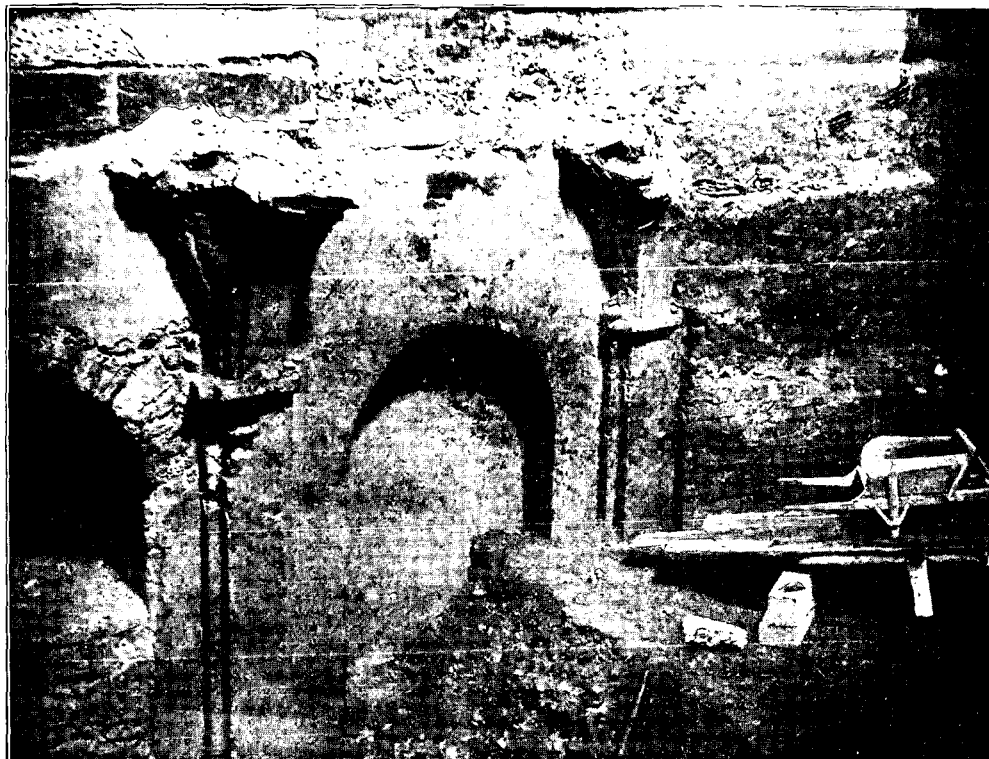
Afb. 5. Noordwand van de oostelijke crypt in de St. Servaaskerk, vóór de restauratie.
