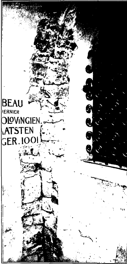
Afb. 10. Scheimuur tusschen kleine crypt en vieringscrypt, noordelijke hoek: geen verband.
