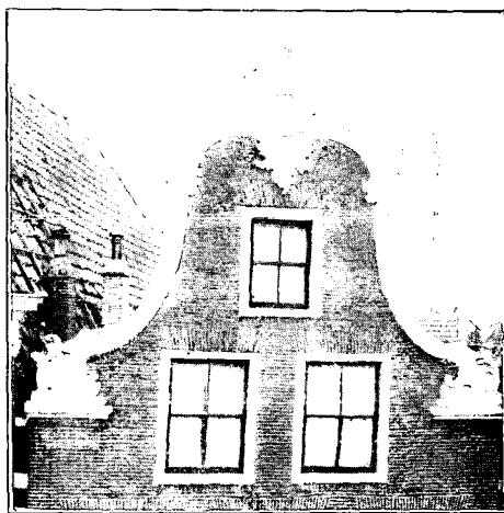
Afb. 40. Top van den gevel, Gr. Noord 50.
