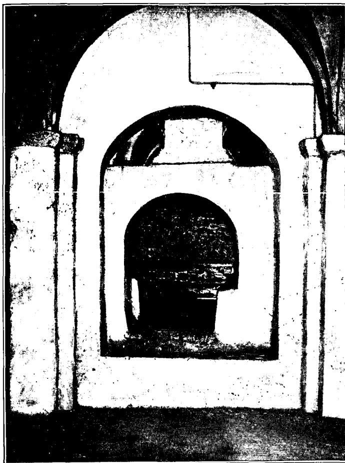
Afb. 11. Doorgang in den muur tusschen de oostelijke- en de vieringscrypt.
