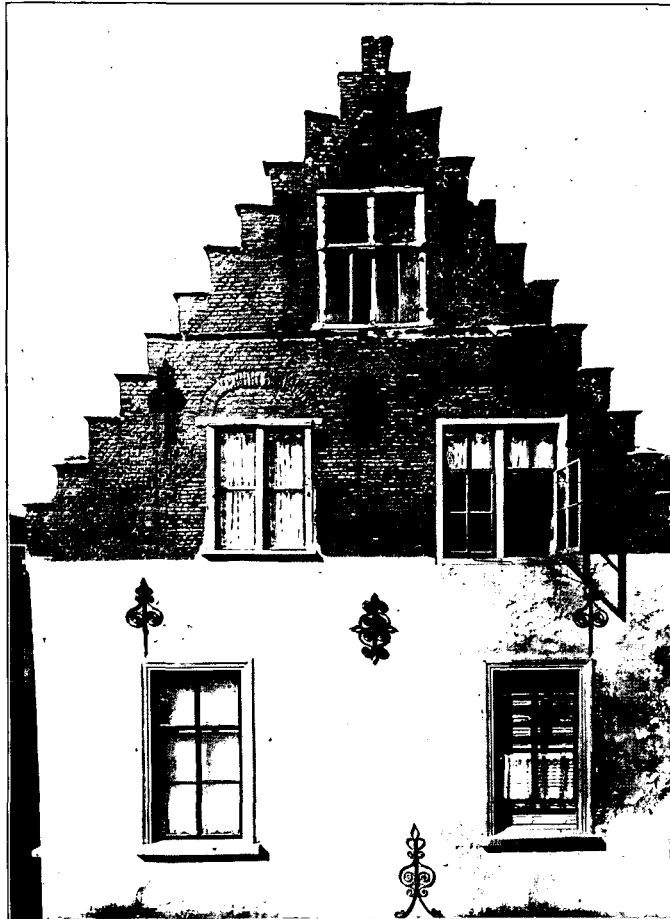
Gevel aan de Torenstraat, hoek Brugstraat.
