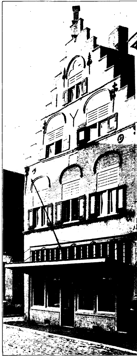
Gevel aan den Haagdijk No.22, na de restauratie.
