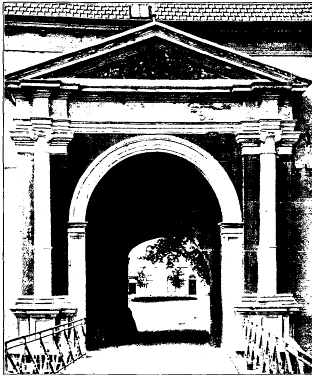
Poort in het zuidelijk voorgebouw van het kasteel.
