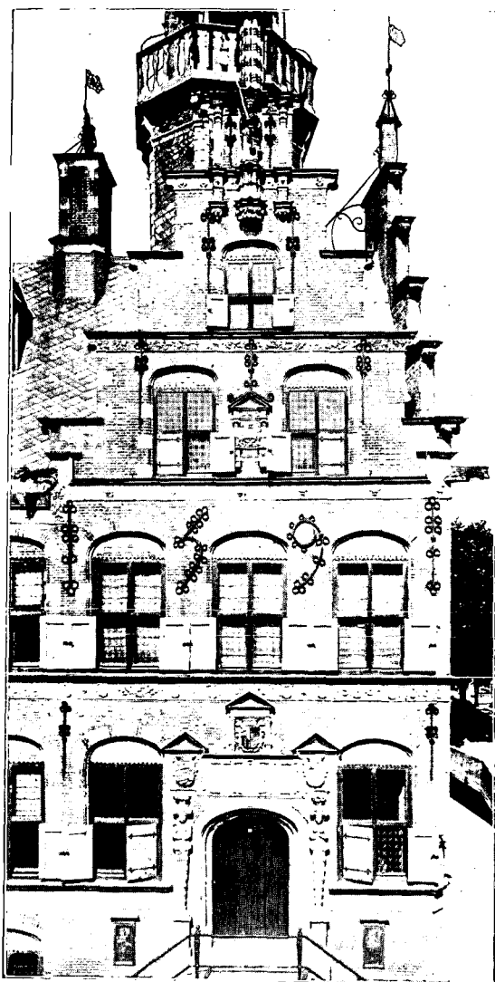
Fig. 37. Détail van het Stadhuis (foto »Friesche Bouwkring«).
