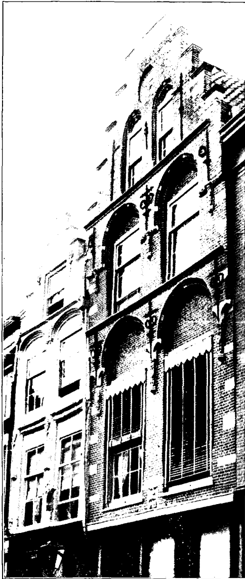
Gevel Groenmarkt No. 31 1).
