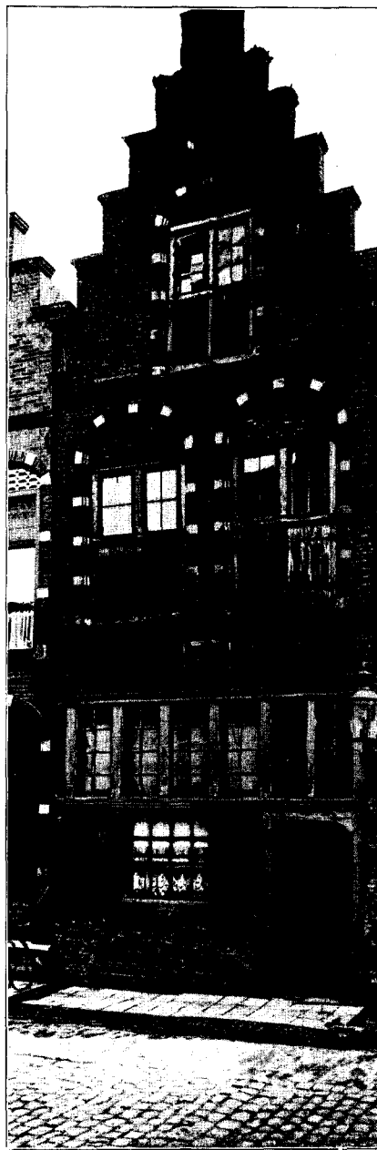
Afb. 10. Gevel Wijdstraat C. No. 18.
