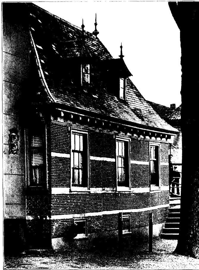
Afb. 14. Sluiswachterswoning aan de Westhaven.
