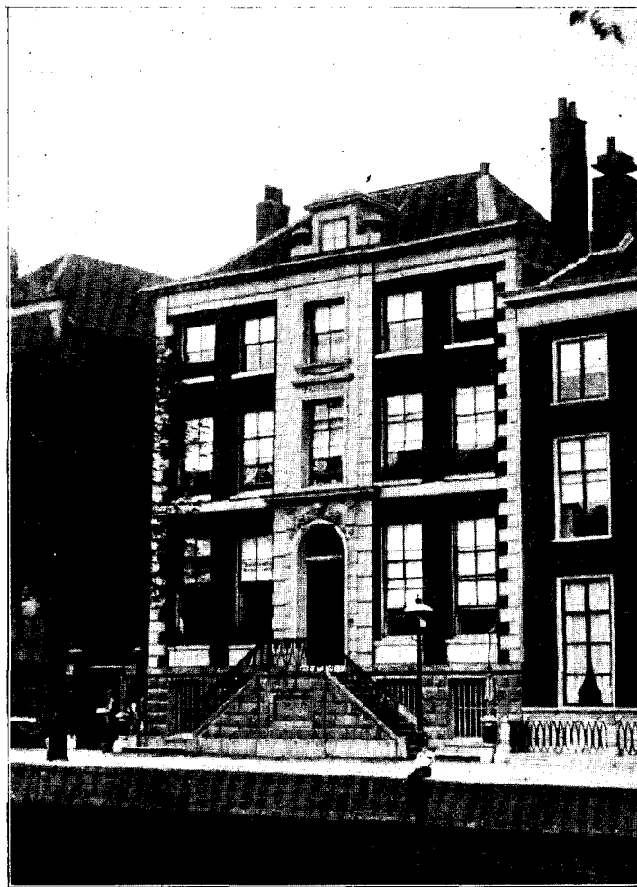
Voorgevel van het huis Lange Haven No. 65 te Schiedam 1).
