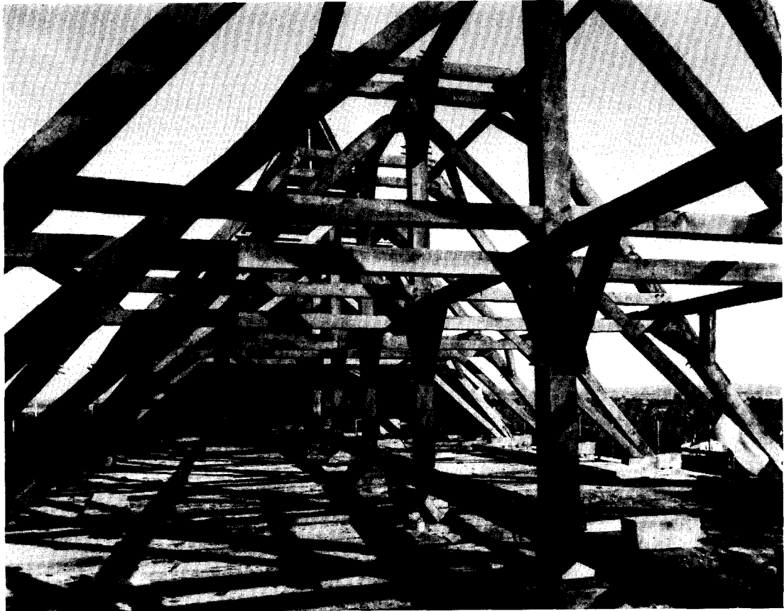
Afb. 4. Doesburg, Grote Kerk, kap van het schip tijdens restauratie.
