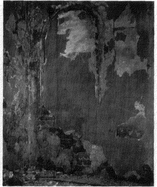
Afb. 4. Vensteromlijsting en resten van middeleeuwse beschildering aan de noordzijde (Foto Monumentenzorg, 1958)
