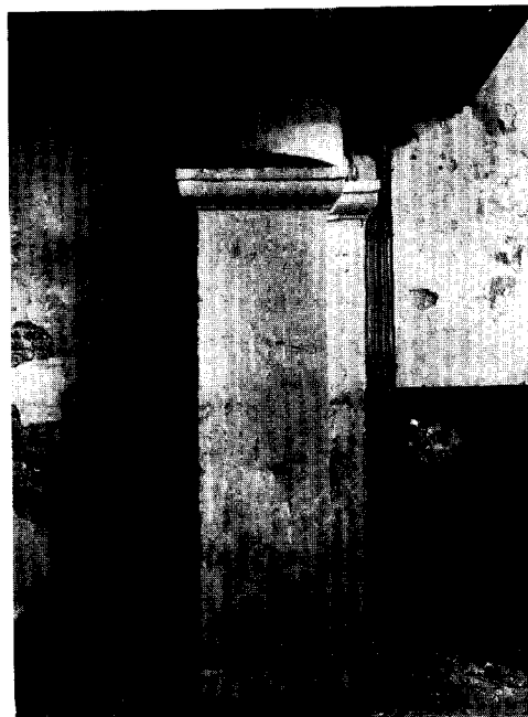
Afb. 10. Pijler I voor de restauratie. (Foto Monumentenzorg, 1966)
