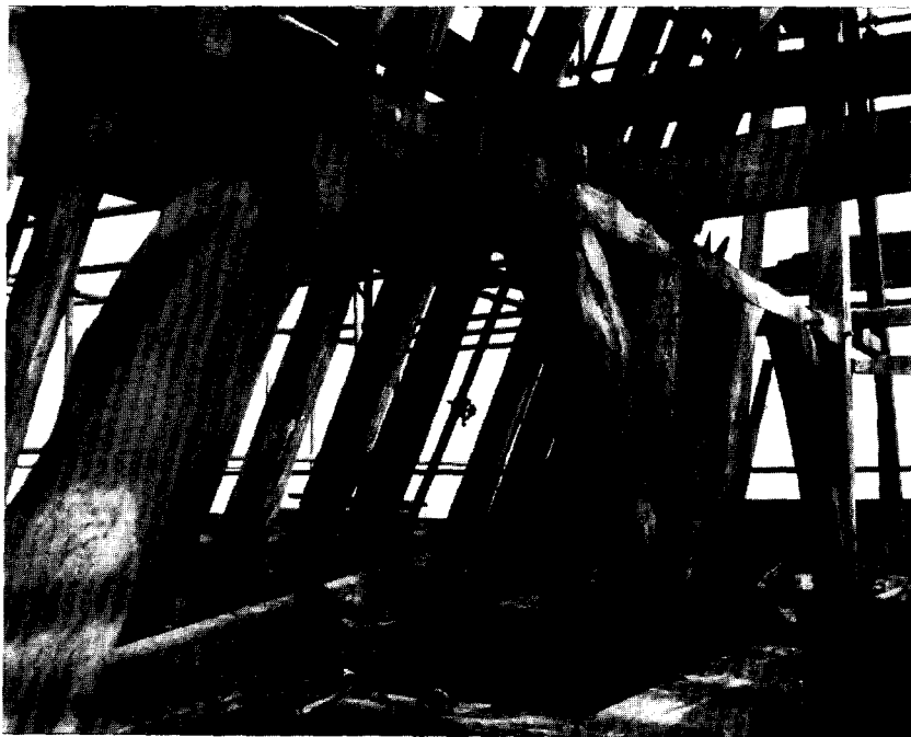
Afb. 2. Kap van de toren boven de spantjukken tijdens de restauratie.
