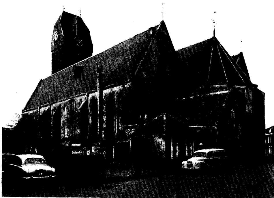
Afb. 4. De kerk uit het zuidoosten voor de restauratie. (Foto Monumentenzorg, 1956)
