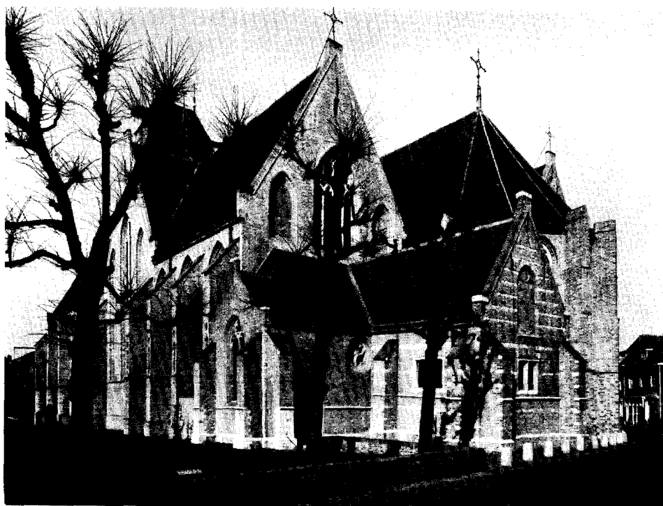
Afb. 5. De kerk uit het zuidoosten na de restauratie. (Foto Monumentenzorg, 1969)
