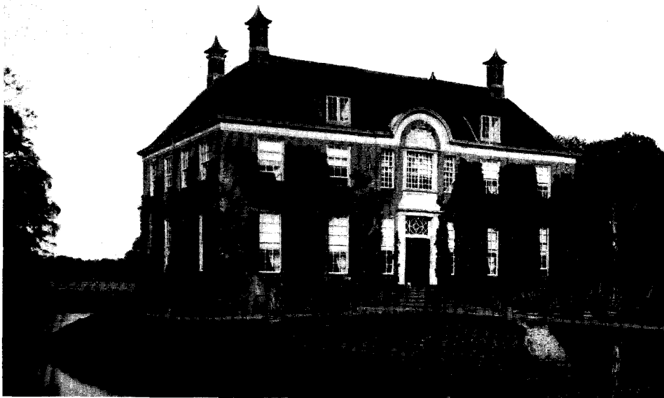
Afb. 12. Den Berg. Type van het eenvoudige 18de-eeuws Overijssels-Gelderse landhuis. In 1705 gesticht door het echtpaar van Dedem-van Delen, wier wapens in het fronton staan gehouwen. De 19de-eeuwse kapelvormige bekroning op de koepelkamer is op de foto weggeretoucheerd. Foto van omstreeks 1914. (Fotocoll. Steenbergh)
