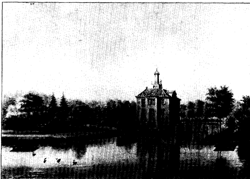
Afb. 1. Oldenaller bij Putten. Vroege hofstede van het centraliserende type. Het huis wordt weleens aan Jacob van Campen toegeschreven. Evenals bij Heemstede, IJsselmonde en Gunterstein vormt een imposante schoorsteen de bekroning van het gebouw. Het in de 17de eeuw zo geliefde uitzichtplat is duidelijk zichtbaar. De hier weergegeven toestand vóór de verbouwing door K. G. Zocher omstreeks 1850, waarbij ook het park gewijzigd werd. Aquareel. (Coll. de erven Jhr. V.E.A. Boreel)
