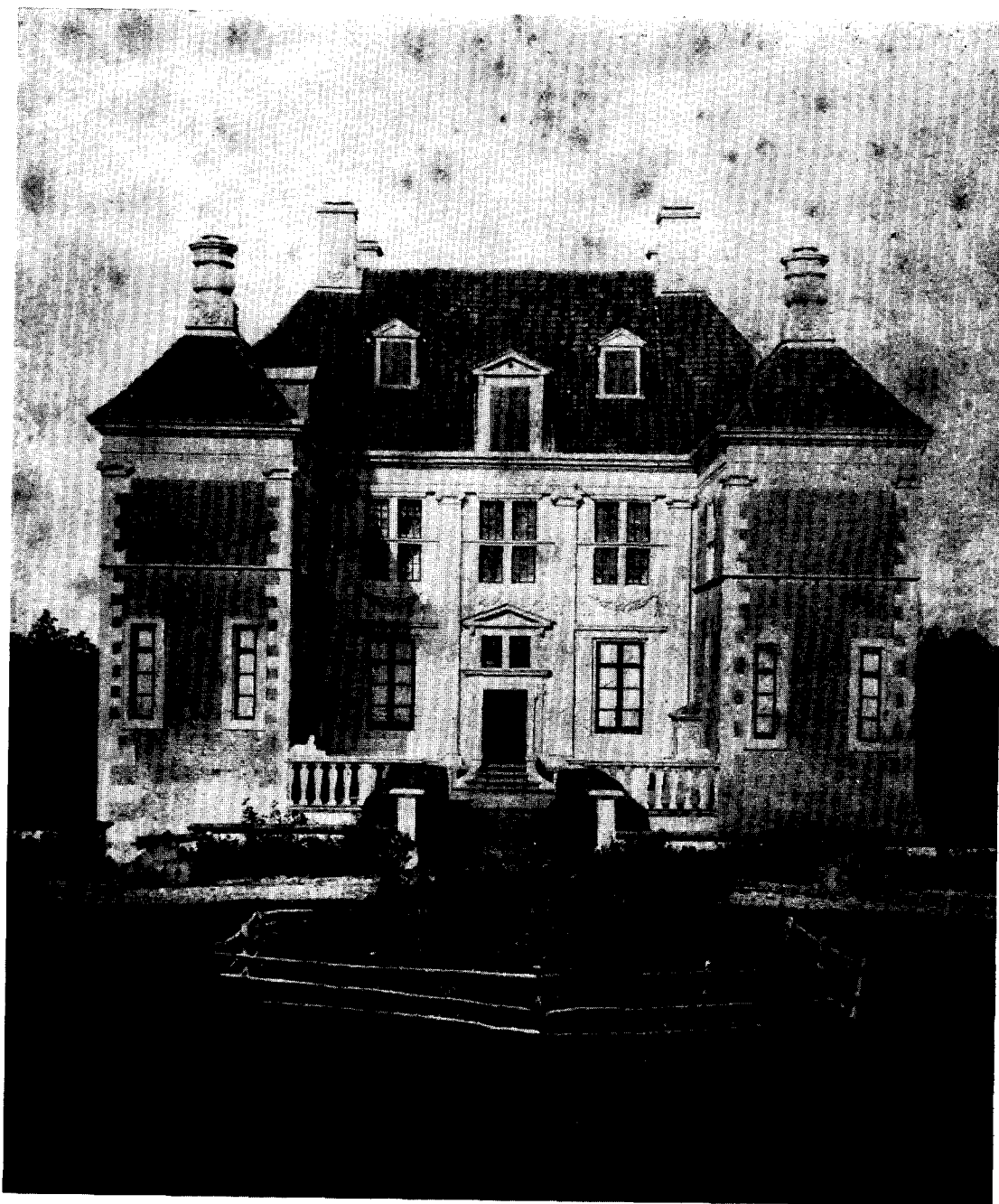
Afb. 17. Het Weldam bij Gooor in zijn oorspronkelijke toestand met de oude roedenverdeling in de kruisvensters op de eerste verdieping, door luiken gesloten dakkapellen, de oude ingangsdeur en het dak met zwart geglazuurde pannen gedekt. Uit het met houten rikpalen omheinde perk op het voorplein spreekt de eenvoud, eigen aan de Overijsselse stijl, die op de Overijsselse buitenhuizen heerste. Foto voor 1877. (Coll. Graaf Solms)
