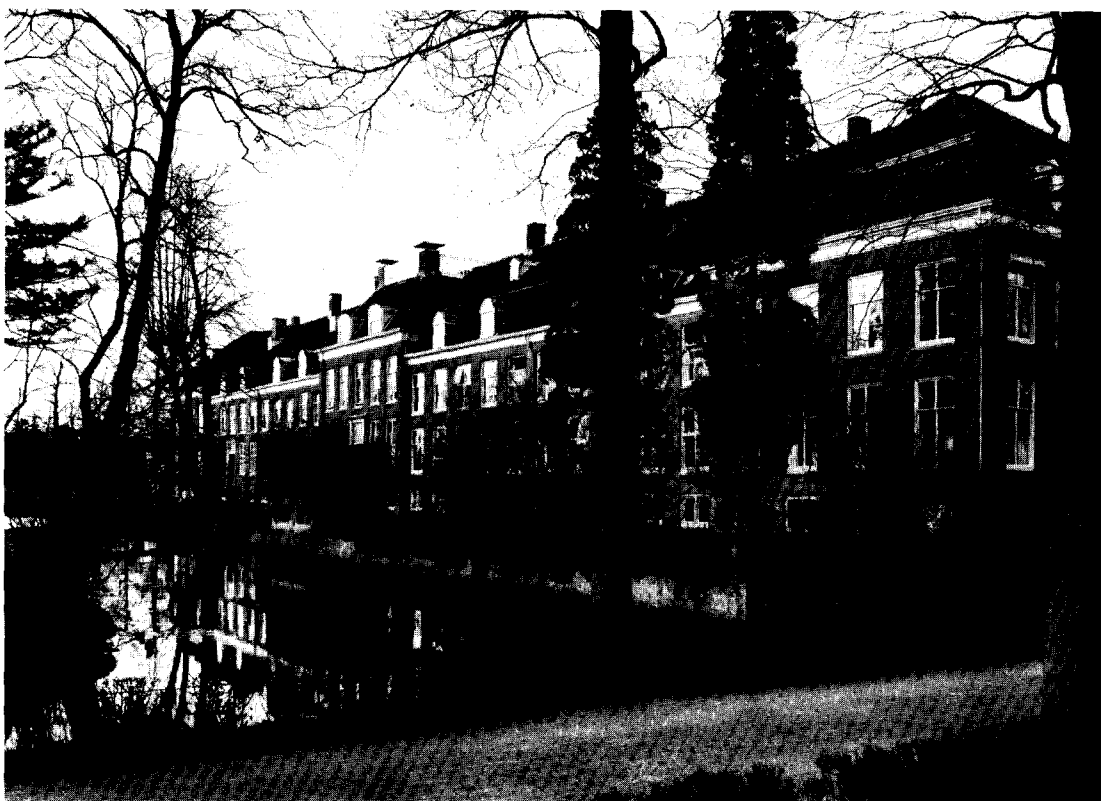
Afb. 8. Overzicht Zusterhuis, Zusterplein 22-22A, achterzijde. (Foto Monumentenzorg 1964).
