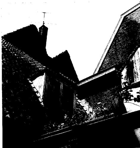
Afb. 13. Buitenhock tussen Broederplein 15A (met dichtgezette zakgoot) en 17 (met intact gebleven zakgoot). Boven de dakkapel het dakvlak van de verhoging in 1777.
