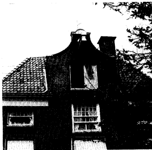
Afb. 14. Achtergevel met hoge middenpartij van Broederplein 33 uit 1777, het enige huis van drie verdiepingen (vgl.afb.11). De bovenste schuiframen verdwijnen achter de kroonlijst. (Foto Kunsthinst. Inst. Utrecht, 1967).
