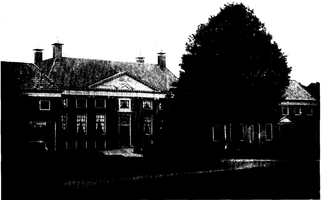
Afb. 3. Fogelsangh State te Veenklooster. De façade voor de verbouwing van 1873.
