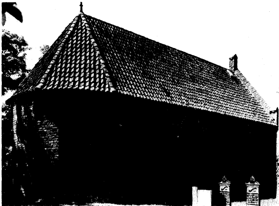
Afb. 5. De kerk uit het noordoosten na de restauratie. (Foto Lit. Inst., Groningen).
