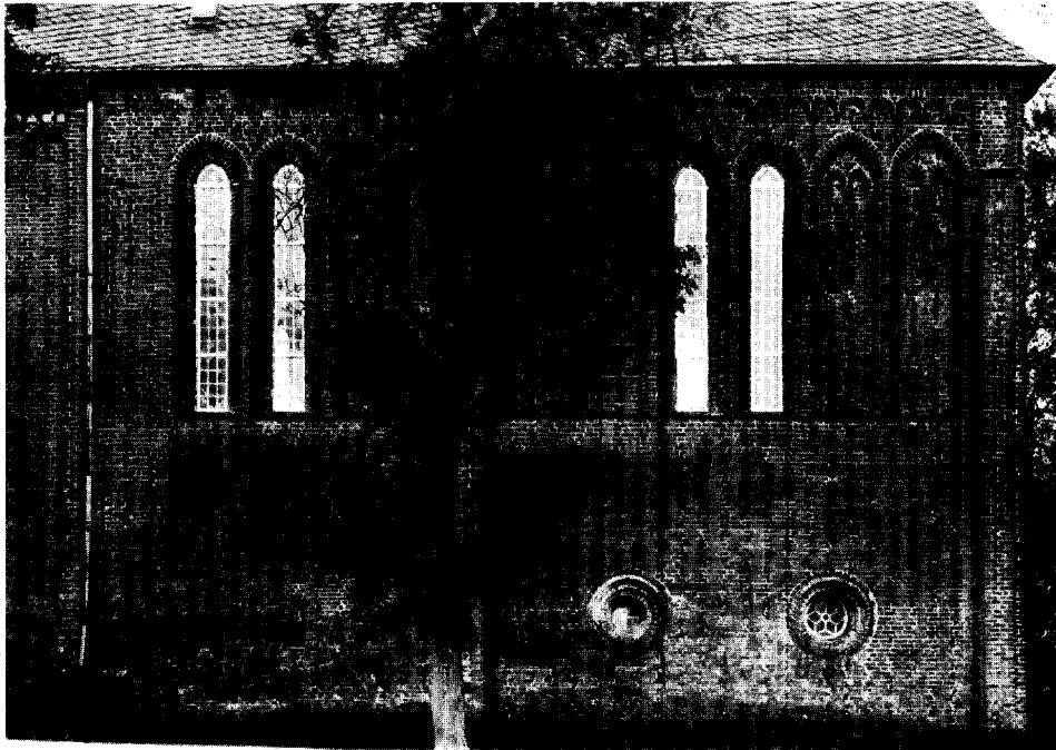
Abb. 12. Engerhufe, Kirche, westlicher Teil der Nordwand.
