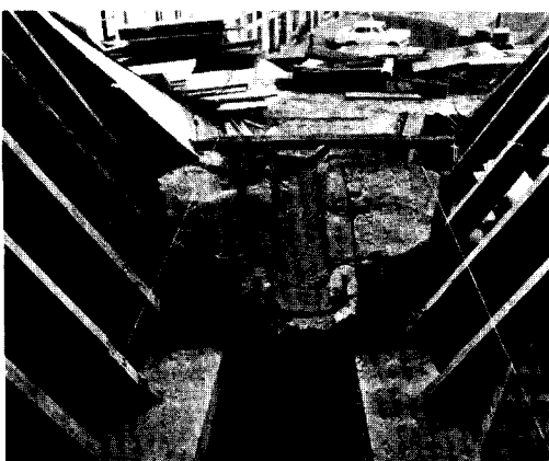
Afb. 26. Voet van een voormalige luchtboogstoel boven de kooromganging. (Foto W. Alkema 1968)
