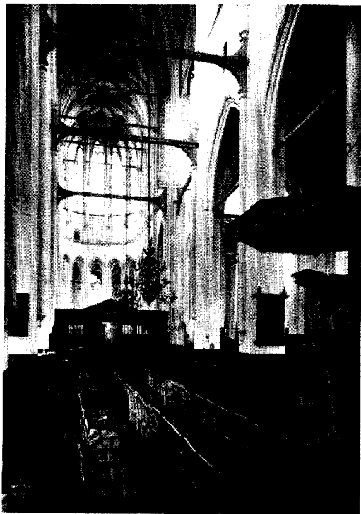
Afb. 10. Interieur naar het oosten voor de restauratie. (Foto Monumentenzorg 1952)
