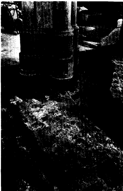
Afb. 35. Basement van een der zuidelijke zijbeukpijlers op de fundering van de eerste gotische kerk. (Foto Monumentenzorg 1963)
