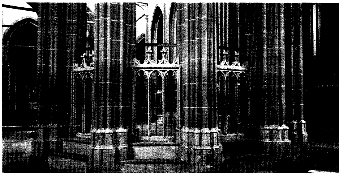
Afb. 19. Koorsluiting, gezien uit de omgang na restauratie.
