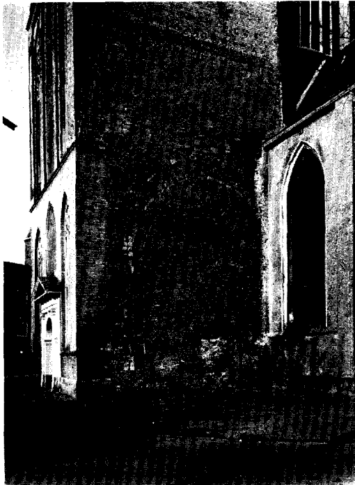
Afb. 7. Zuidelijke torenwand met dichtgezette boog van de eerste gotische kerk en gewelfmoe- ten uit de eerste en laatste gotische periode. (Foto Monumentenzorg 1959)
