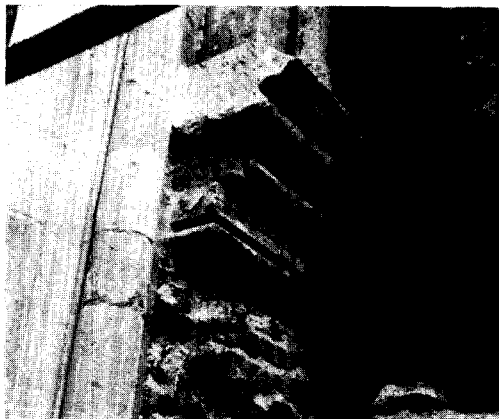
Afb. 25. Overblijfsel van een gereduceerd triforium in de zuiderdwersarm. (Foto Monumentenzorg 1963)
