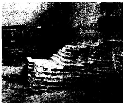
Afb. 27. Fundering in het westen van de noordbeuk. (Foto Dienst IJsselmeerpolders)
