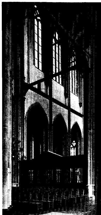
Afb. 17. Noordzijde van het koor na restauratie.
