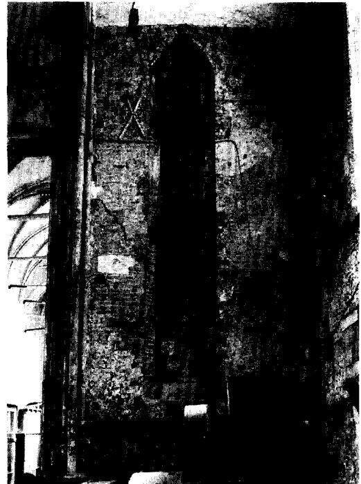
Afb. 8. Oostwand van de zuiderdwersarm van de eerste gotische kerk met dichtgezet venster en res- tant van een muraalboog. (Foto Monumentenzorg 1959)
