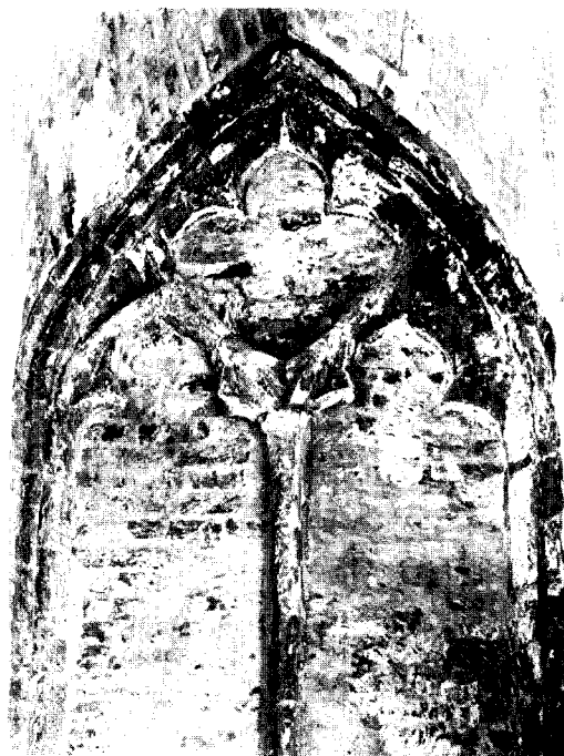
Afb. 21. Tracering in de zuidwand van de middelste straalkapel. (Foto Monumentenzorg 1966)
