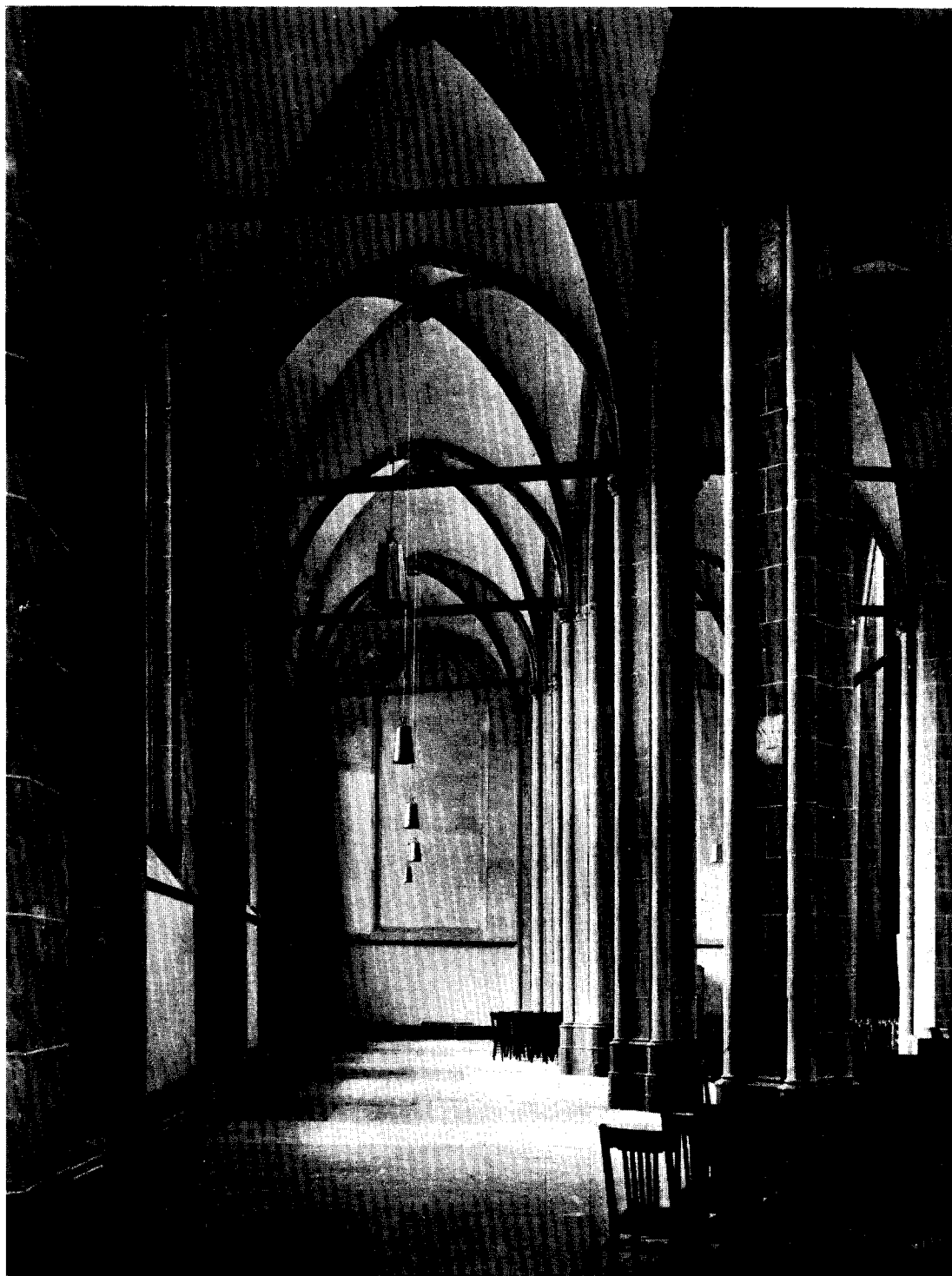
Afb. 34. Zuidbeuk naar het westen na restauratie.
