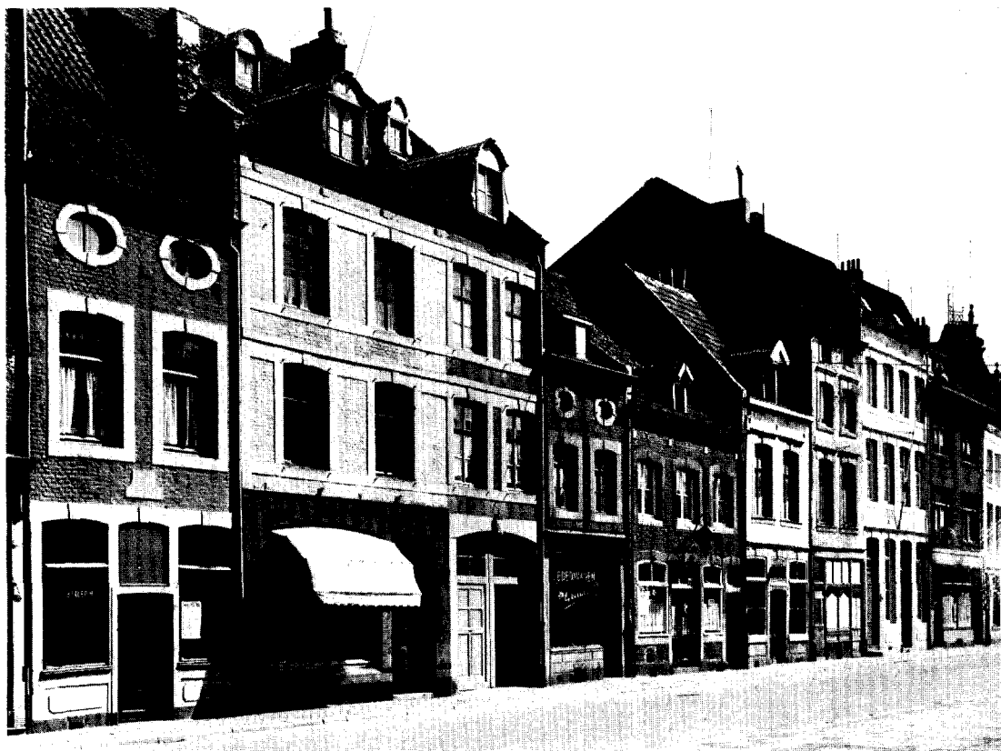
Afb. 14. Hogebrugstraat 18 tot 2, Wijk. Gevels met segmentboogvensters. -18 met gevel (In den witten Engel 1765) voor ouder pand. -18 en 14 met voor Wijk typische ovale zoldervensters. -16 met overbouwde zijplaats en hoge tweede verdieping voor woondoelenden, twee zolders in de kap en gevel van \pm 1770. In 1803 werd 18 bewoond door een kleermaker; 16 was herberg, van de familie Corver, een groot gezin, met twee knechten en een dienstbode; 14 was het woonhuis van een graanhandelaar. (Foto Monumentenzorg 1957).
