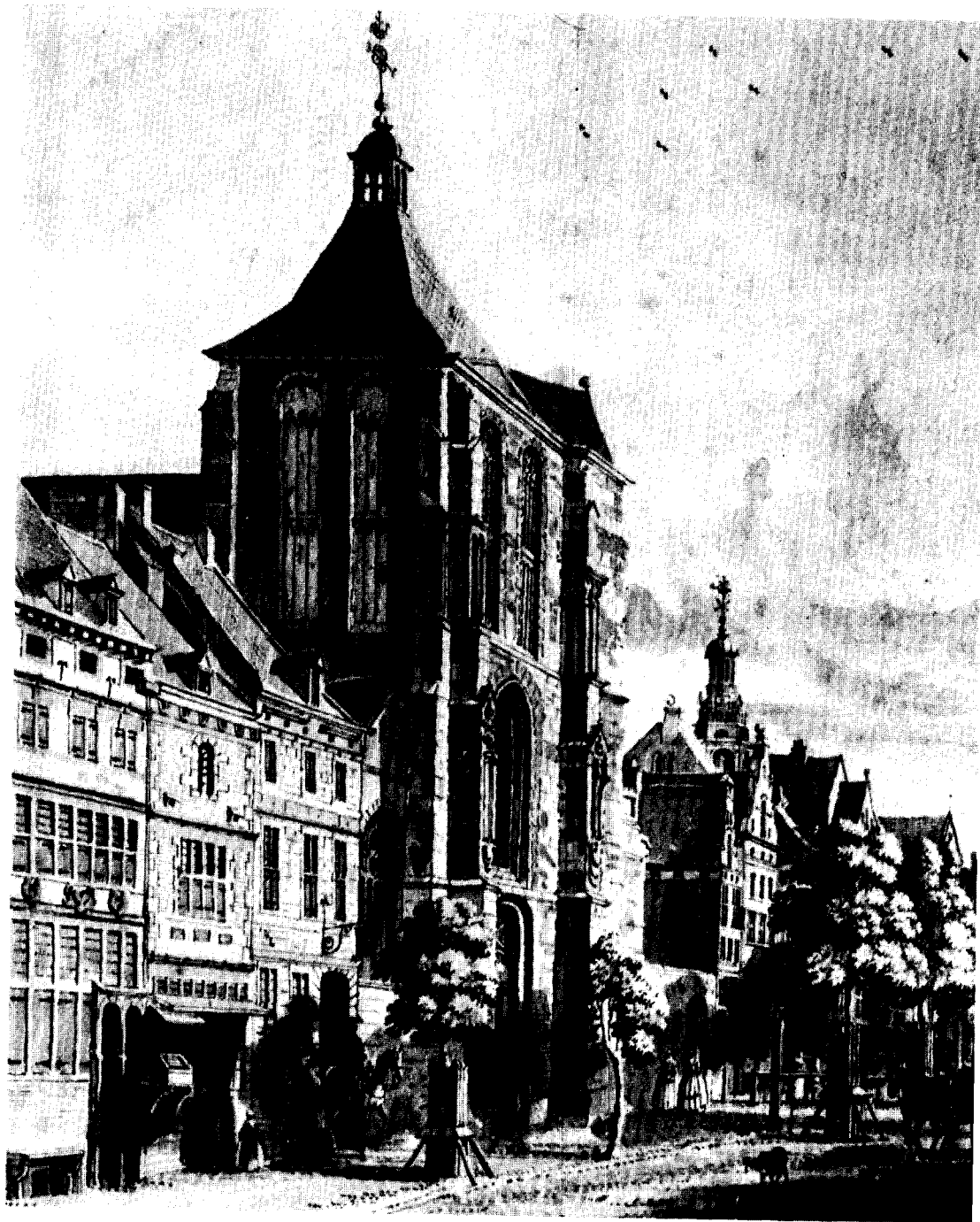
Afb. 7. Boschstraat 93, 95, 97, St.-Matthiaskerk e.v. Tek. Jan de Beijer 1740, detail (Stadsarchief Maastricht). -93 en 95 met 17de-eeuwse gevels, 97 begin 18de eeuw. Tweede verdiepingen voor berging. -93 met twee ingangen, de rechter voor een gang naar de achterplaats. -95 winkelhuis. -97 herberg huisingang tevens doorgang naar achterplaats.
