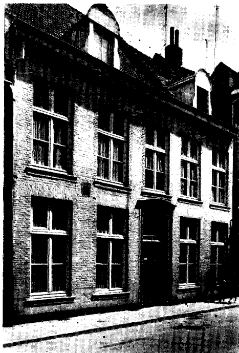
Afb. 16. Capucijnestraat 51. Gevel ± 1775, houten vensters zonder natuurstenen omlijstingen. (Foto Monumentenzorg 1962).
