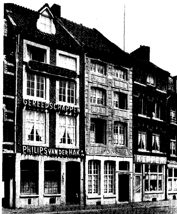
Afb. 11. Cörversplein 11, 12 en 13. -12 met middel-eeuws houtskelet en natuurstenen gevel: 1740 in de Grudtmolen. Oorspr. natuurstenen kruiskozijsen van Maastrichts type en deur in het midden. (Foto Monumentenzorg 1957).
