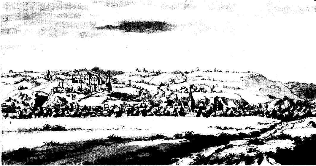
Afb. 1. Gezicht op Valkenburg met het kasteel vanuit het Geuldal. Tekening 1669, toegeschreven aan Josua de Grave. (Maastricht, Limb. Gesch. en Oudh. Gen.).
