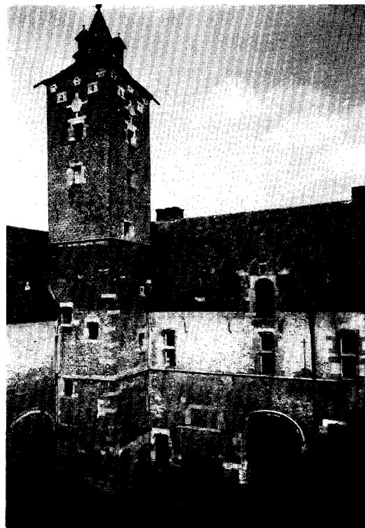
Afb. 7. Alden Biesen, binnenplaats van het hoofdgebouw naar het noordoosten. (Foto Kon. Inst. Kunstpatrimonium 1943).
