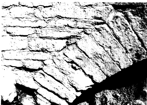
Afb. 12. Detail van het metselwerk van de brug.
