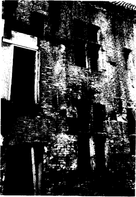
Afb. 8. Achtergevel van het gebouw Papestraat 11/13 met oorspronkelijke bakstenen kruisvensters, tijdens de restauratie. (Foto 1973).
