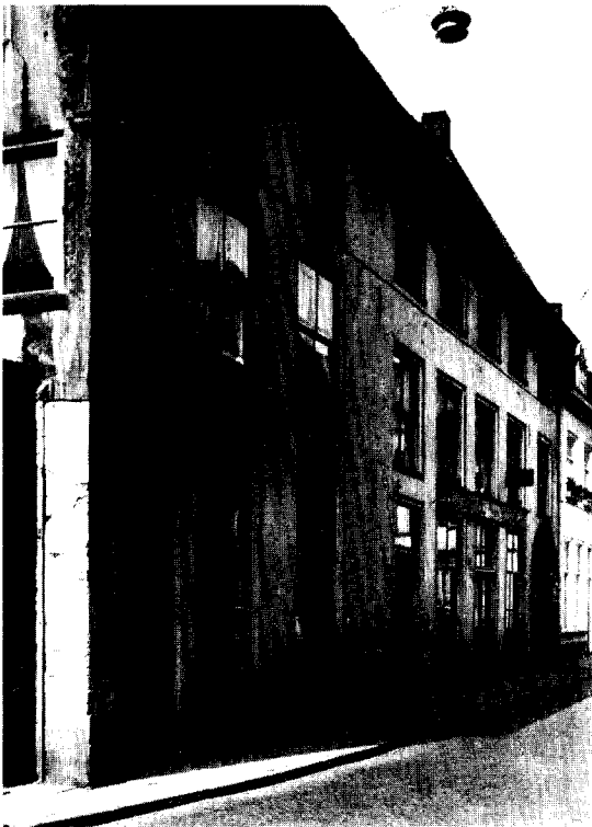
Afb. 6. Voorgevel van het gebouw aan de Praubstraat met rechts de poortdoorgang naar de binnenplaats. (Foto 1962).
