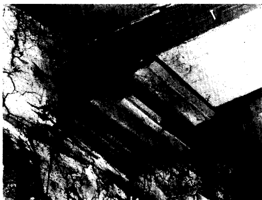
Afb. 12. Diezerstraat 2. Gotische console onder balklaag zonder kinderbinten. (Foto Monumentenzorg).
