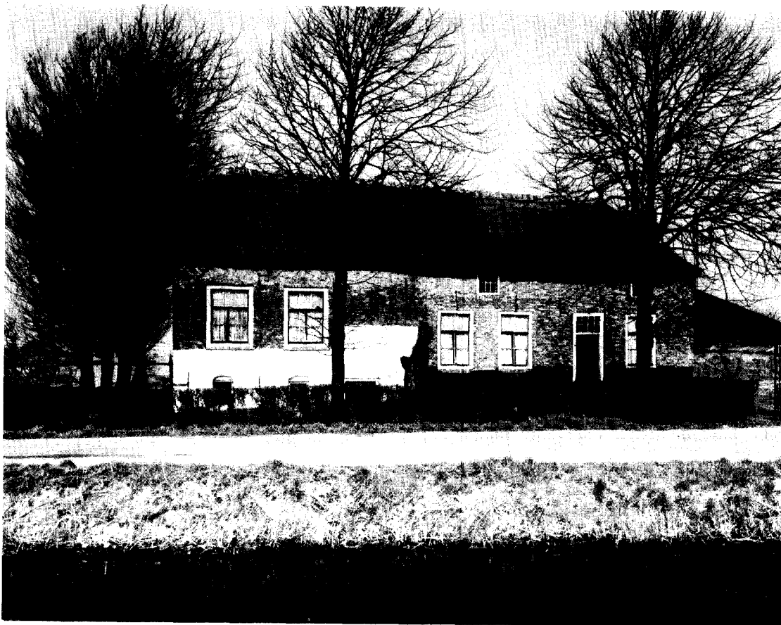
Afb. 1. Boerderij aan de Westgaag nr. 74 in Maasland. (Foto Monumentenzorg 1971).
