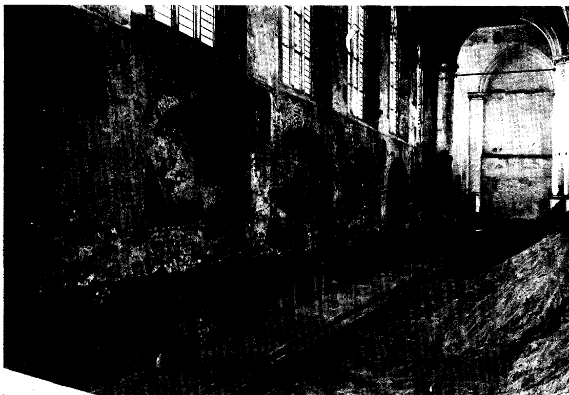
Afb. 3. Wijk bij Duurstede, Hervormde kerk. Interieur van de half uitgegraven noorder zijbeuk; onder de linkse korfboognis de afgebroken fundering van de westmuur van de vroeg 15de-eeuwse zijbeuk. (Foto G. Berends, mei 1974).
