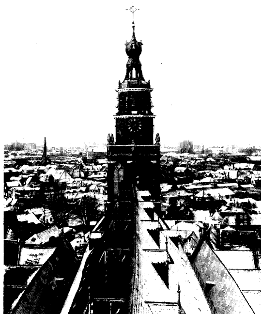
Afb. 8. St.-Janstoren in Gouda. Detail van de loodbedekking. (Foto G. Th. Delemarre, Rijksdienst voor de Monumentenzorg, 1965).
