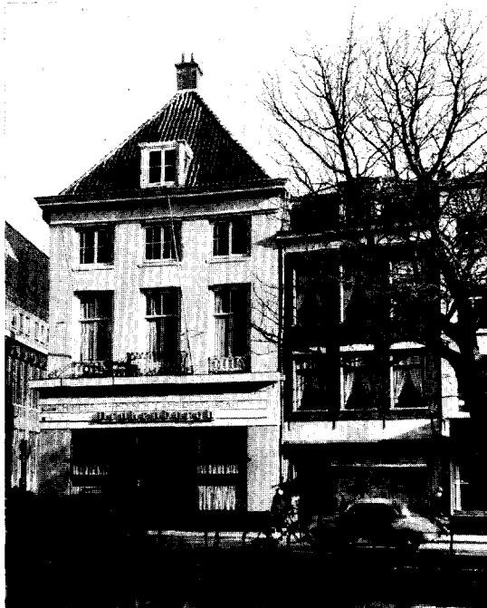
Afb. 3. Huis Drakenburg voor de restauratie. (Foto C. L. Temminck Groll 1958).
