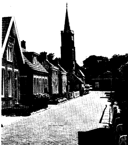
Afb. 31. Usquert, toren N.H. kerk (1869), vanuit het zuidwesten. (Foto C.F.D. 1974).
