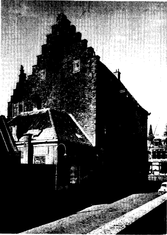
Afb. 5. Huis Drakenburg, achtergevel en zijgevel gezien vanuit de Drakenburgstraat voor de restauratie. De linker trapgevel is het achterhuis van het aangrenzende Klein Drakenburg. (Foto Monumentenzorg 1952)
