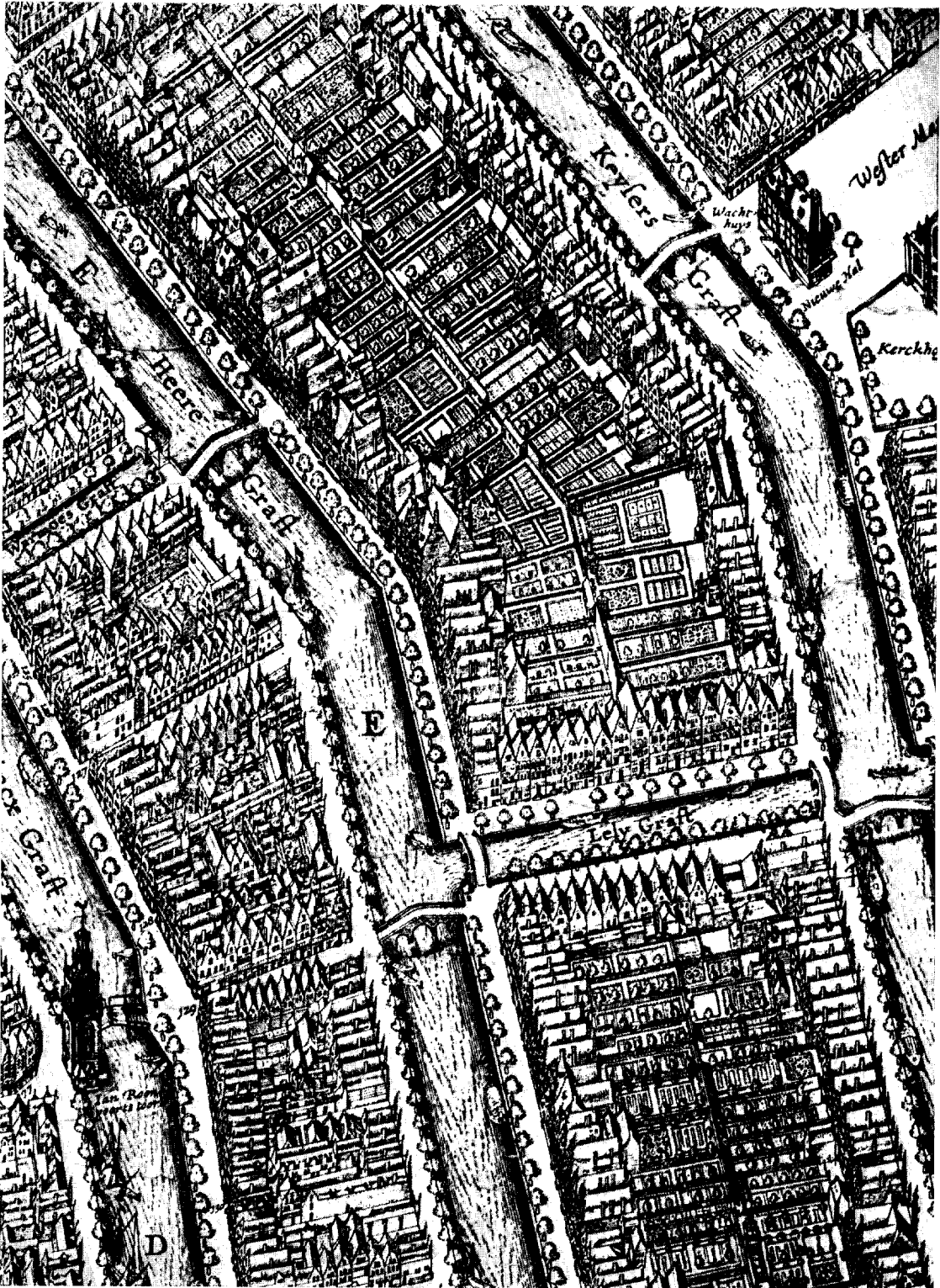
Afb. 1. Detail van de kaart van Balthazar Florisz. uit 1625. Op de Leliegracht zijn hele rijen trapgevels te zien. 90% van de huizen op het deel van de grachten tussen het IJ en de Leidsegracht bezat in 1625 een trapgevel. In 1767 is dit nog maar 25%.
