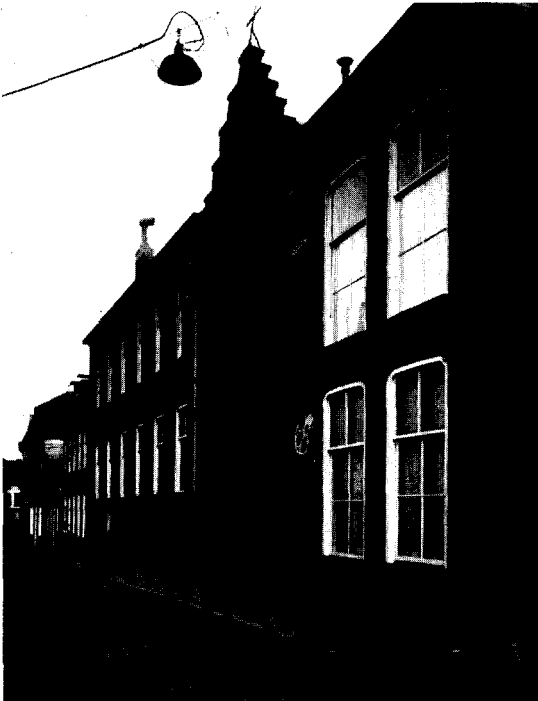
Afb. 25. Liefdegesticht, de uitbreiding van 1870: de kapel (met trapgevel) en links daarvan de zalen; in 1936 grotendeels afgebroken. (Foto uit archief Mariapension).
