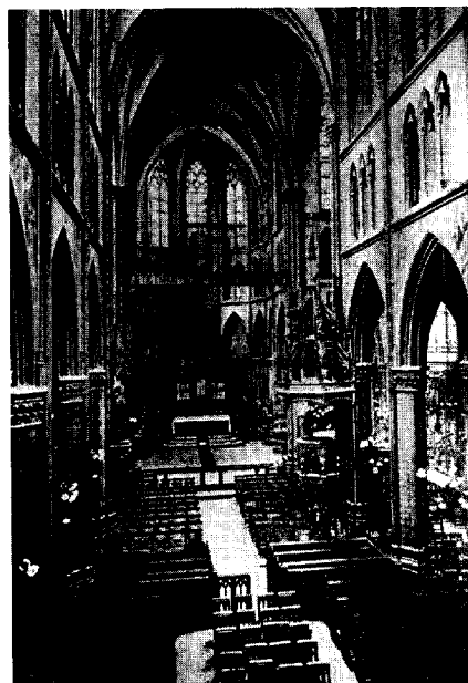
Afb. 15. Amsterdam, Redemptoristenkerk. (Foto uit J. Kalf, De Katholieke Kerken in Nederland , Amsterdam 1906.)
