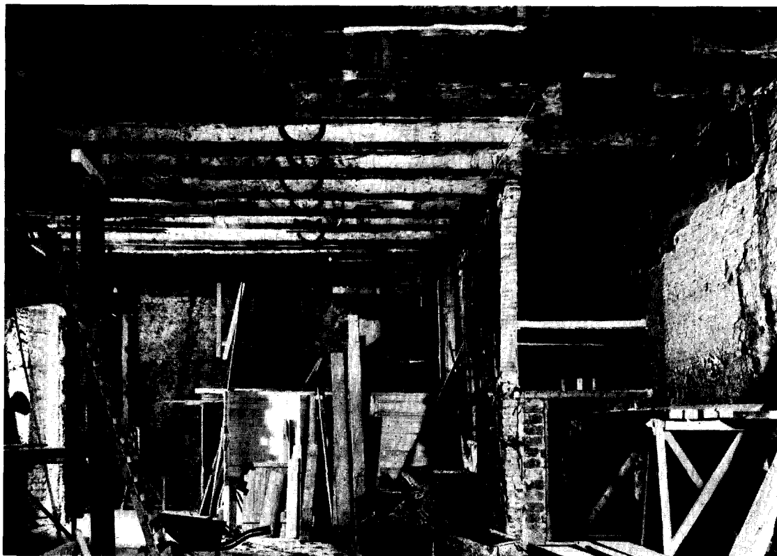
Afb. 9. De restauratie van huis Drakenburg. Interieur van de begane grond gezien naar het oosten. Rechts is de grens van het tufstenen muurwerk zichtbaar. Moerbalken van gewit dennenhout met een zwarte banddecoratie. (Foto Monumentenzorg 1966)
