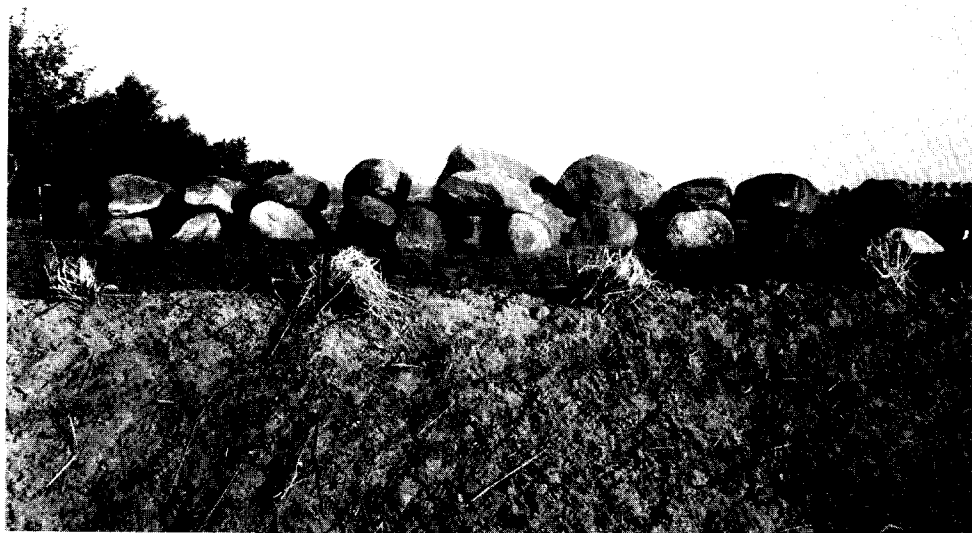
Afb. 3 en 4. Het hunebed van Balloo, voor en na de restauratie in 1952, resp. vanuit het Z.W. en het Z.
