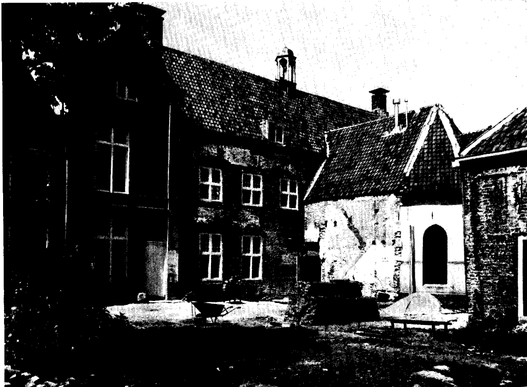
Afb. 2. De achtergevel van de hoofd vleugel van het gasthuis met de kapel. (Foto Monumentenzorg, A. v. d. Wal, 1973)
