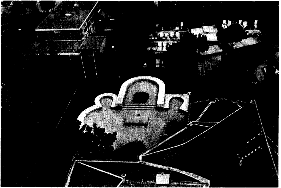
Afb. 2. Monument voor de Graven van het Hollandse Huis, gezien vanaf de toren te Rijnsburg. De in 1613 uitgebroken fundamenten van het klaverbladvormig koor van de abdijkerk — waarvan de met puin gevulde uitbraaksleuven in 1949 en 1951 werden onderzocht — zijn bovengronds zichtbaar gemaakt door laag muurwerk. Voor het hoofdkoor bevindt zich de tombe waarin de stoffelijke resten van de te Rijnsburg begraven leden van het Hollandse Huis in 1975 opnieuw zijn bijgezet. Rechts van het hoofdkoor de Gravenkapel.
