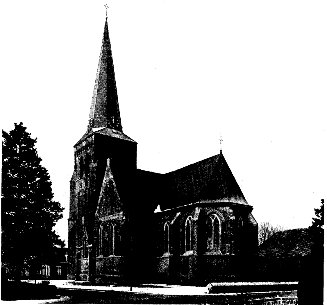
Afb. 2. De Hervormde kerk in Helvoirt gezien vanuit het zuidoosten.
