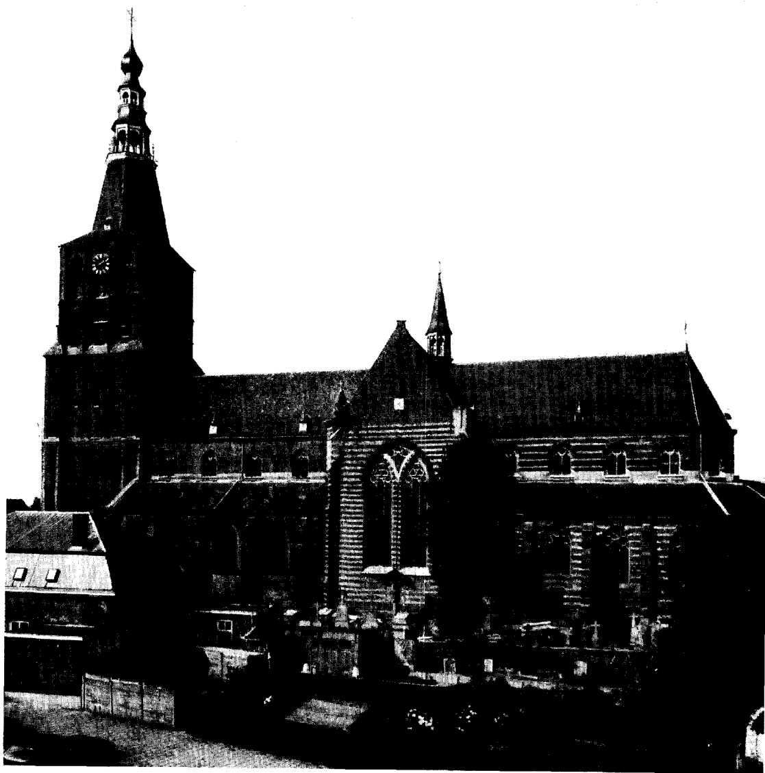
Afb. 1. Aanzicht vanuit het zuiden, 1975.
