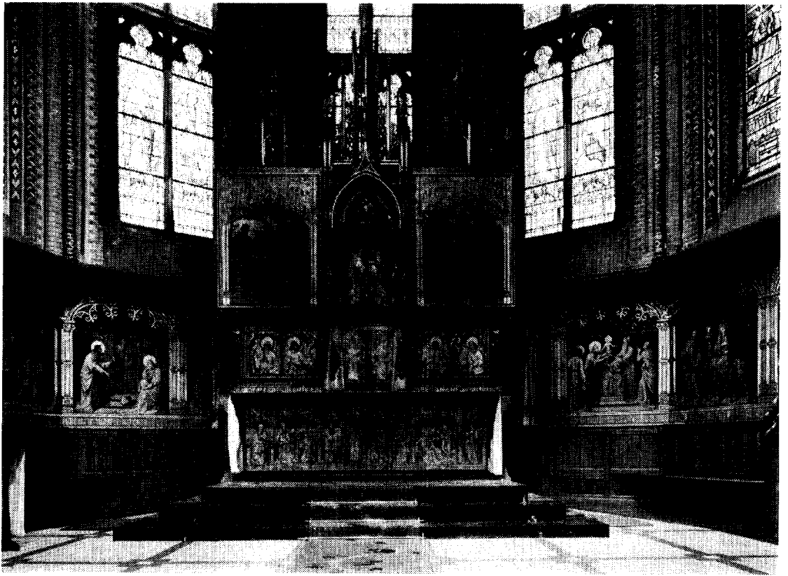
Afb. 10. St.-Jozef, koorsluiting met hoofdaltaar (dagkant). (Foto CFD Groningen, 1971).
