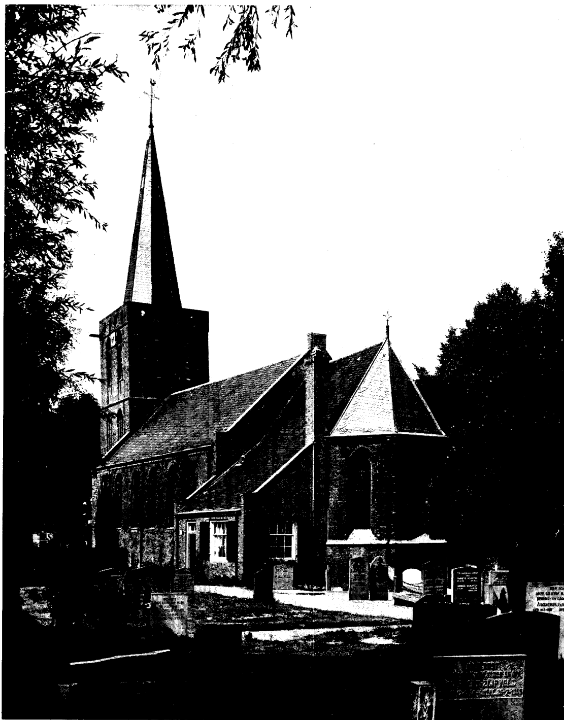
Afb. 1. De Hervormde kerk te Kortenhoef gezien vanuit het zuidoosten na de restauratie.
