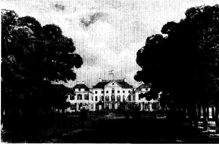
Afb. 40. Voorzijde van Het Loo ten tijde van Koning Willem III, aquarel door C. van Borselen omstreeks 1860, behorende tot de serie aquarellen van Het Loo en omgeving die Koning Willem III zijn nicht, prinses Marie, dochter van Prins Frederik bij haar huwelijk aanbood.
