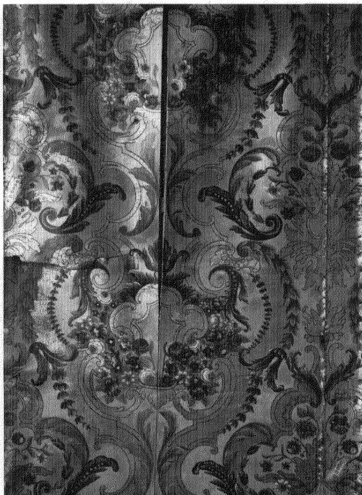
Afb. 1. Goudleer in de rechter voorkamer van Huis Voormeer te Heerenveen voor de restauratie. (Foto Monumentenzorg, A. J. van der Wal, 1974).
