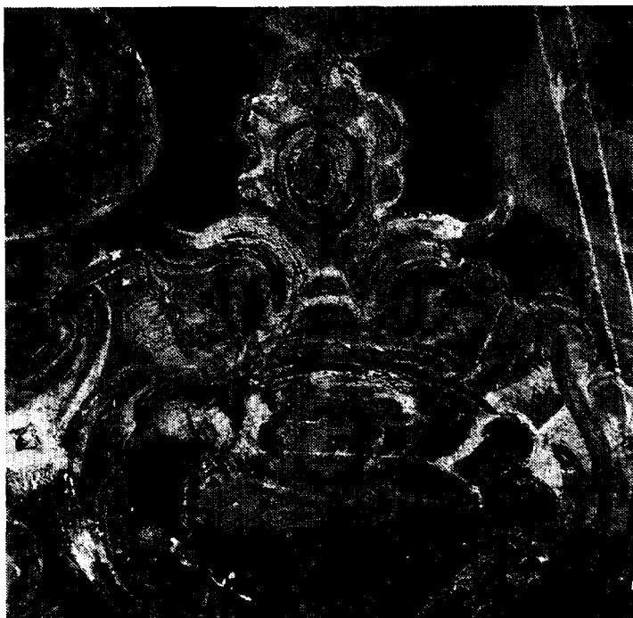
Afb. 7. Schelpmotief met engelenkopje boven een van de kapitelen op het gewelf aangebracht in de toestand voor de reiniging, juli 1971. (Foto Monumentenzorg, G. Dukker).
