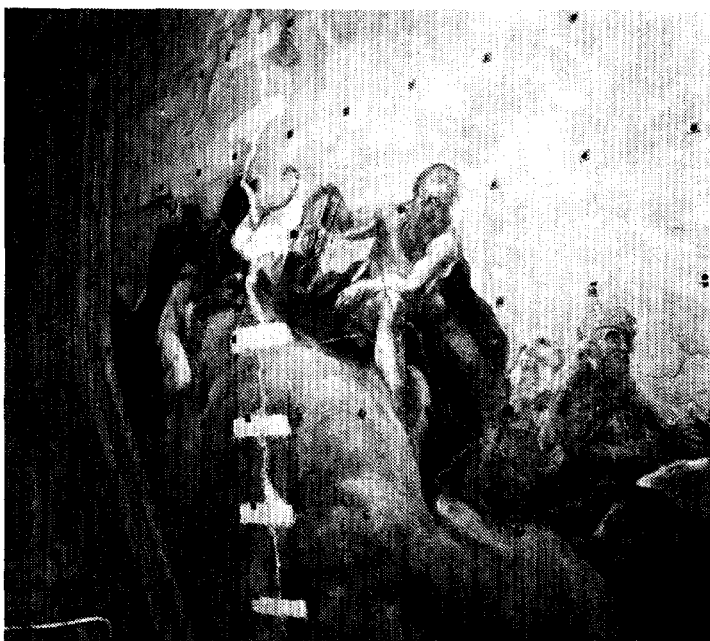
Afb. 14. Gekramde barst in het westelijk gedeelte van het gewelf aan de zuidzijde tussen de gestalten van de kerkvaders Augustinus en Hieronymus vóór de retouchering.
