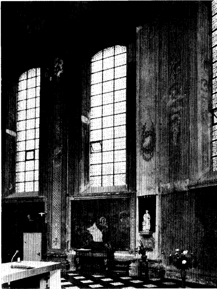
Afb. 4. De noord-oosthoek van het koor met rechts de resultaten van een proefreiniging en links een nog niet gereinigd gedeelte. De wandtaferelen zijn nog onaangeroerd. Onder het venster van de koorsluiting op doek geschilderde Louis XV-motieven. (Foto Monumentenzorg, G. Dukker, april 1972).
