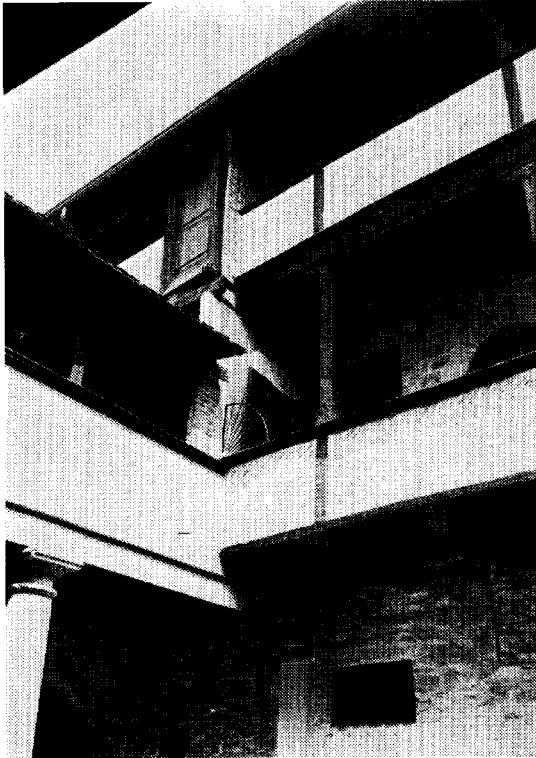
Abb. 23. Innenhof der Casa Bazzi nach der Restaurierung: Das ursprüngliche Holztragwerk und die Ziegelfüllungen der Balkonbrüstungen kamen zum Vorschein.
