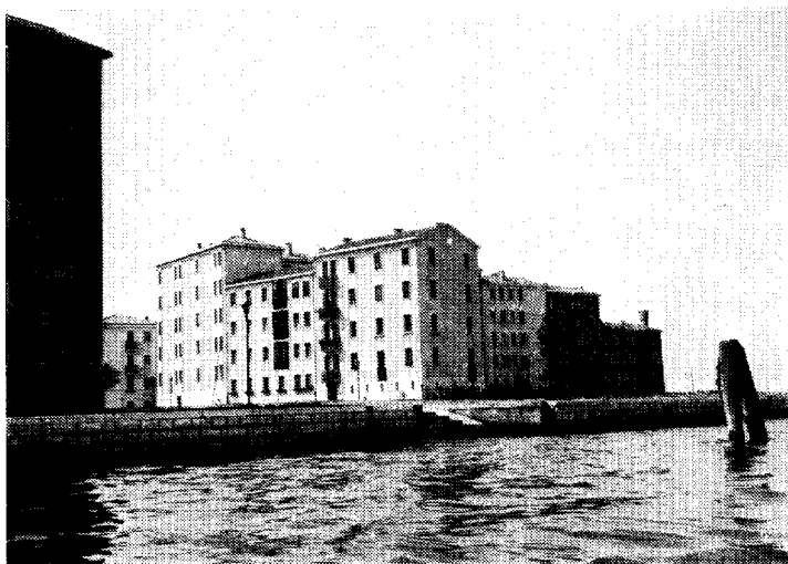
Abb. 2. Neue Volksquartiere an der Peripherie: Venedig, Sacca Fisola (zu Grundsituation 1).
