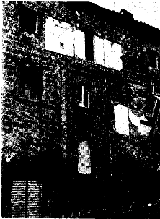
Abb. 17. Tuscania nach dem Erdbeben: Alle aussen angefügten WC's und sonstigen störenden Anbauten wurden sofort demoliert, um eine korrekte Sanierung zu gewährleisten.
