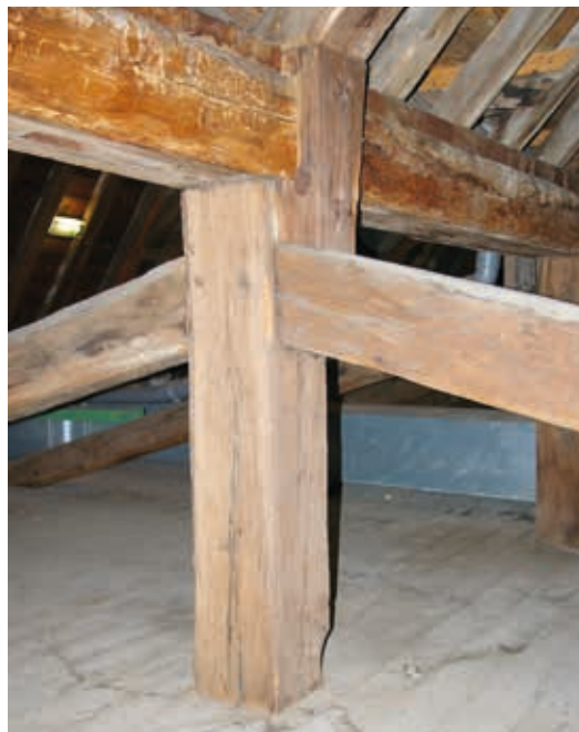
26. Detail van de aan twee zijden afgeschoorde korte stijl in het midden van de constructie die de zakgoot draagt (foto R. Stenvert, 2009)
