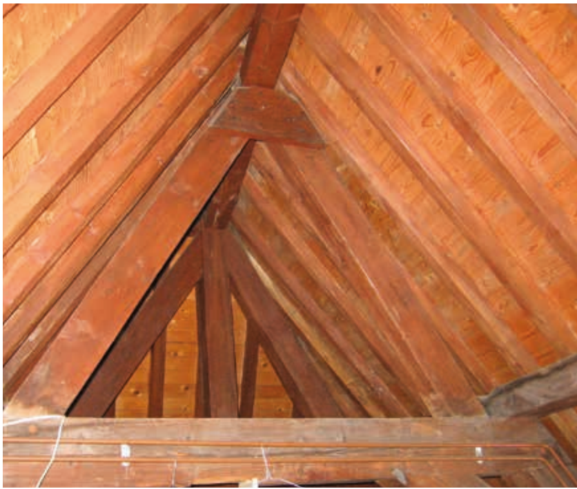
20. Nokconstructie van de kap van het poortgebouw van het Hofje Meermansburg. Onder de nokgording bevindt zich wat een houten schetsplaat genoemd wordt (foto E. Orsel, 2007)
