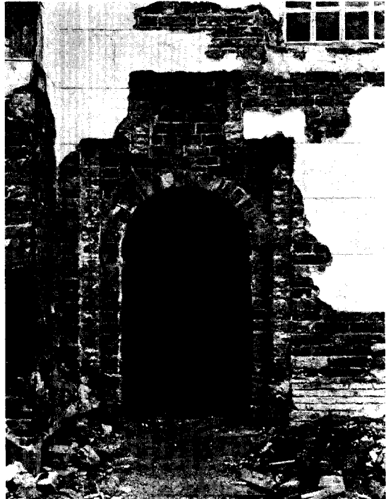
Afb. 12. Oorspronkelijke toegang in de noordmuur van het schip vermoedelijk daterend uit het eerste kwart van de 13de eeuw. (Foto Monumentenzorg, januari 1976).
