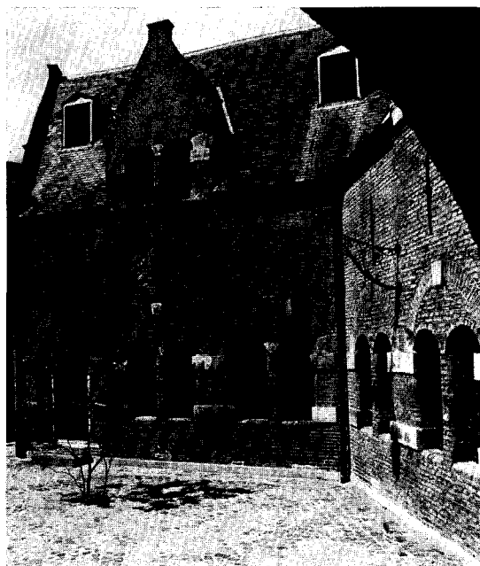
Afb. 9. Gevels binnenplaats van het Kruituis. (Foto Frans Kuit 1975).
