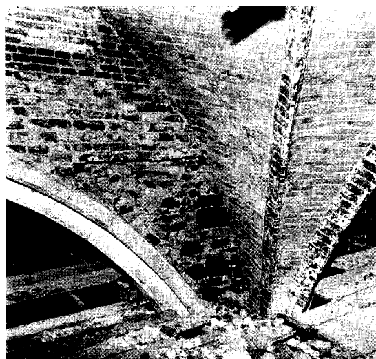
Afb. 7. Overblijfselen van ijzeroer in de zwikken van de drie westelijke traveeën met daarboven in baksteen de verhogingen van 1520 en 1888. (Foto Monumenten- zorg, maart 1975).
