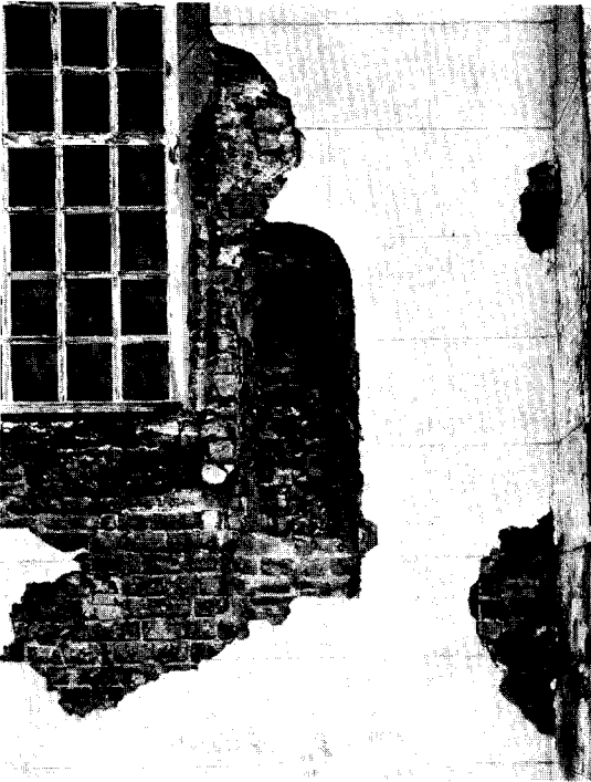
Afb. 11. Romaans venstertje in de zuidmuur van het schip, waarschijnlijk ingebroken tijdens de verhoging van het schip of iets later. (Foto Monumentenzorg, januari 1977).
