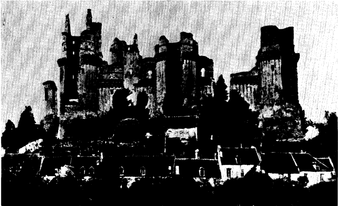
Afb. 5. De ruïne vanuit het noordwesten, gefotografeerd in 1855. (Foto Monuments Historiques, 2148).
