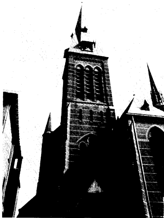
Afb. 2. Den Haag, H.H. Engelbewaarders, toren uit het westen.
