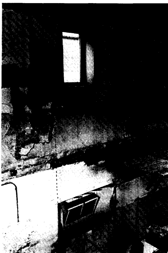
Afb. 28. Noordmuur van de rechthoek, travee 2. Resten van het oorspronkelijk venster. Rechts onder, in travee 1, het ampulnisje.
