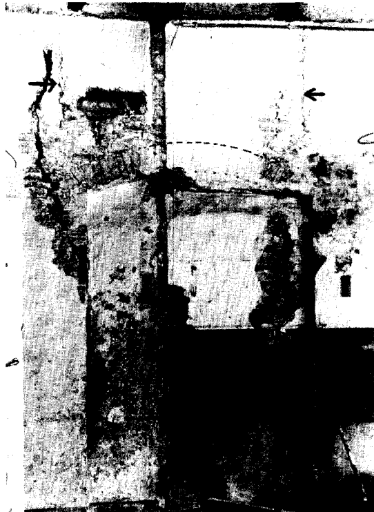
Afb. 25. Noordmuur van de rechthoek, travee 3. De oorspronkelijke ingang. Bij de pijlen de kanten van het venster. Door de scheur links heeft de toemetseling van de ingang een dragende functie gekregen.
