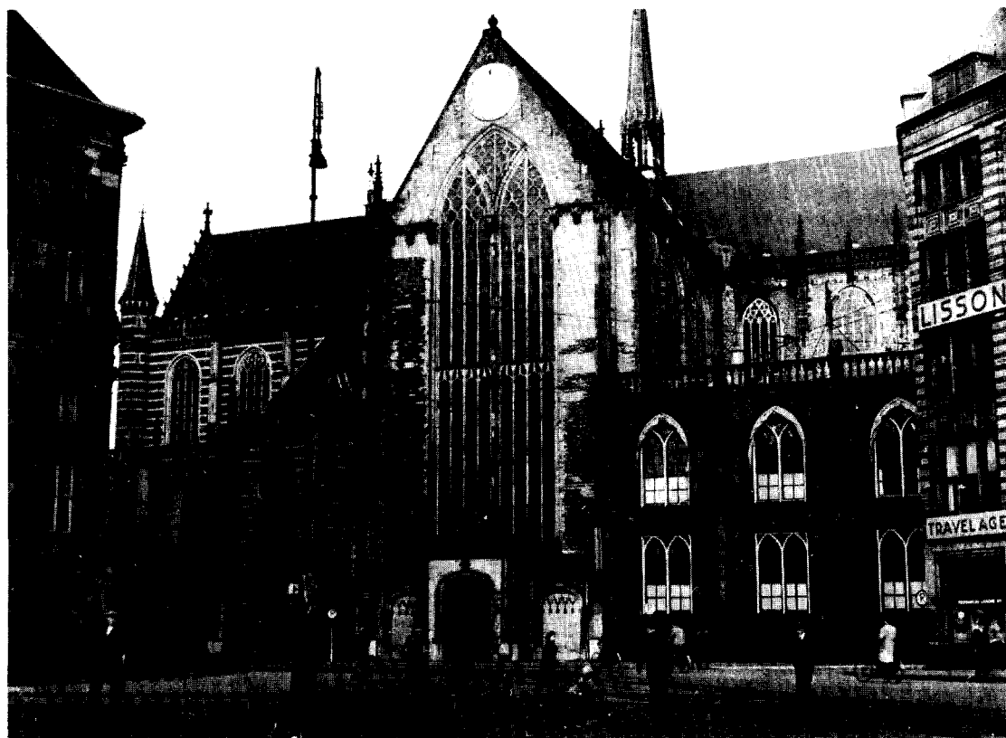
Afb. 2. De Nieuwe Kerk met de in 1859 gebouwde neogotische consistorie. Opname uit 1940.
