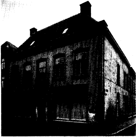
Afb. 18. Roermond, Swalmerstraat 38. (Foto Monumentenzorg, 1954).
