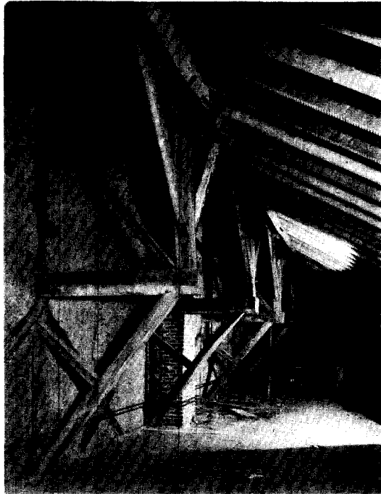
Afb. 9. Ondersteuningsconstructie van het noordelijk dakvlak van de noordvleugel met de in vakwerk uitgevoerde scheidingswand tussen de zolderruimte van deze vleugel en de noordelijke kruisgang. Vergelijk afb. 3.
