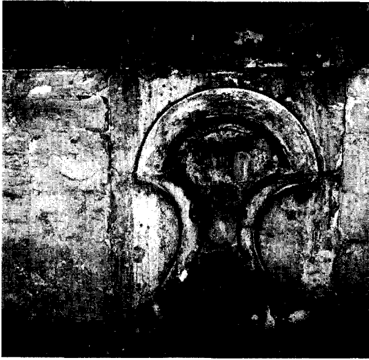
Afb. 7. Sleutelgatvormige opening in de oostmuur van de westvleugel boven de gewelven van de Langegang. Links is de diamantkoppelijst zichtbaar. (Foto Monumentenzorg, 1980). (Foto Monumentenzorg, 1980)
