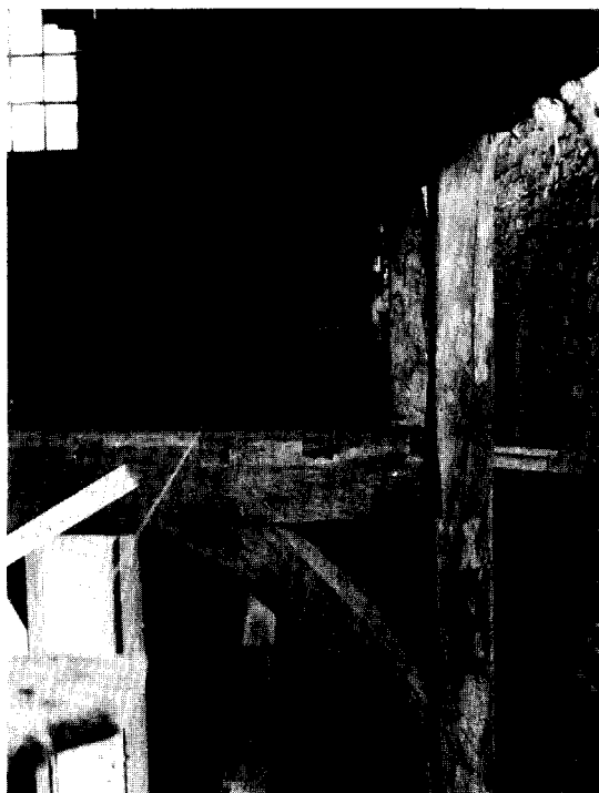
Afb. 20. Eiken ankerbalkconstructie van het voorhuis. Op de moerbalk staan de eveneens eiken krommers van het kapsant op de zolderverdieping. (Foto N. Boschma)
