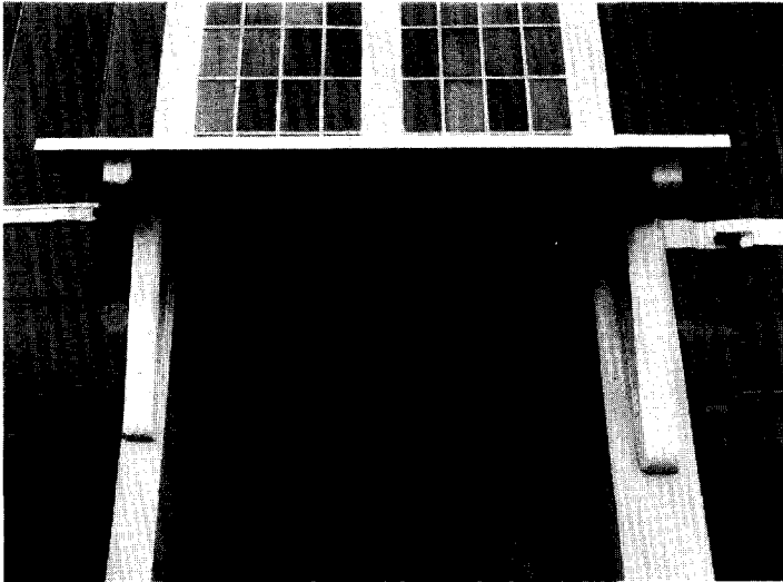
Afb. 11. Het kalf van het voordeurkozijn met peerkraalversiering na de restauratie. Tot nu toe werd de ouderdom van het pandje aan de hand van dit detail bepaald op ca. 1540.
