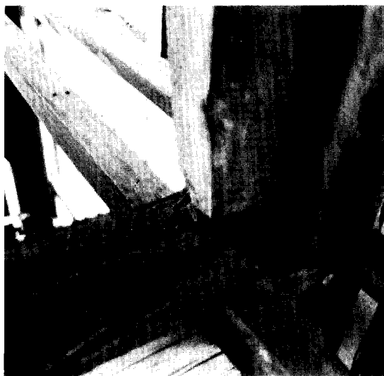
Afb. 10. Toegepast „hamerkopanker”.
