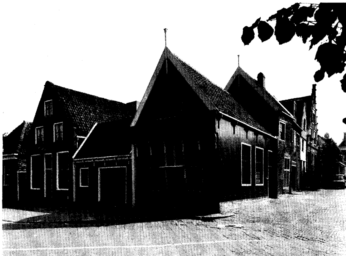
Afb. 24. Overzicht van het huis Achterhaven 105 met de belendingen. Links van de smalle gevel van het houten huis: Achterhaven 103, pakhuisje behorend bij bakkerij Gorter; nr. 101 de bakkerij, welk pand in 1595 gebouwd is door de erfgenamen van Pieter Ysbrantsz ter vervanging van een ouder huis.
