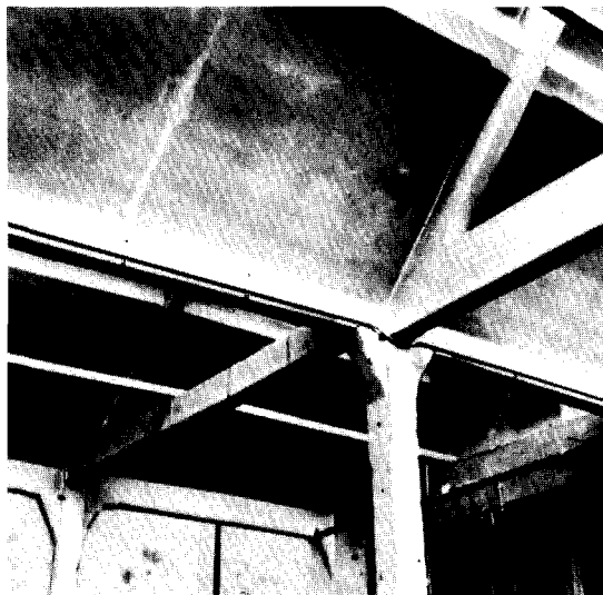
Afb. 6. In betonconstructie uitgevoerde sheddaken in de uit 1908 daterende fabrieksuitbreiding. (Foto Gemeentewerken, 's-Hertogenbosch)
