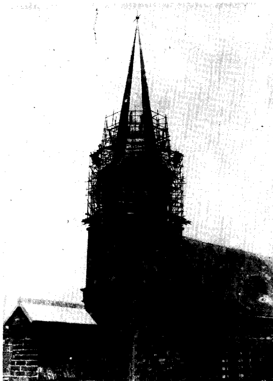
Afb. 52. De toren van de Grote kerk tijdens de bouw van de nieuwe spits omstreeks 1939. (Foto Verz. Prentenkabinet, Leiden)
