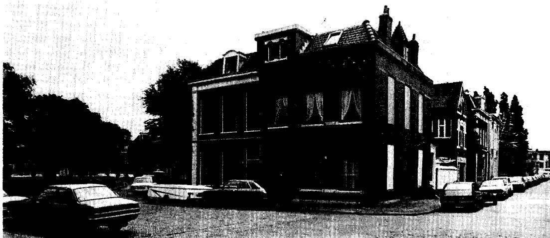
Afb. 19. Ripperdapark nrs. 10-12, opname 10 juli 1978. (Foto Monumentenzorg Haarlem, Jos Fielmich)
