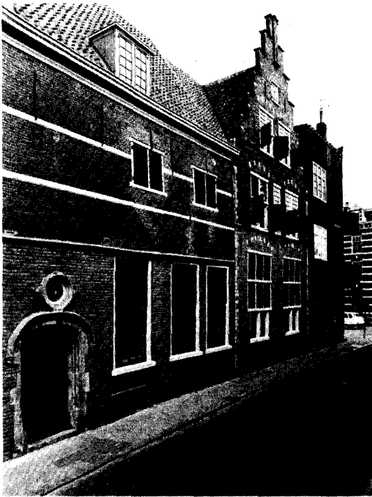
Afb. 5. De voormalige Bank van Lening, gerestaureerd in de jaren 1972-1976, tegenwoordig in gebruik ten behoeve van diverse bestemmingen, waaronder boekwinkel, restaurant en uitgeverij. (Foto Monumentenzorg Haarlem, Jos Fielmich, 1976)
