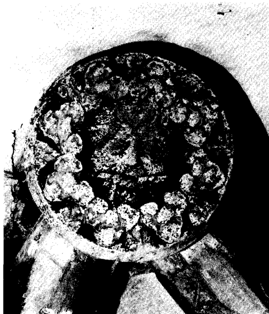
Afb. 9. Sluitsteen van het gewelf van de koorsluiting. De bladeren staan op ranken die in het gezicht ontspringen. Toestand voor de restauratie. (Foto P. van Vliet)
