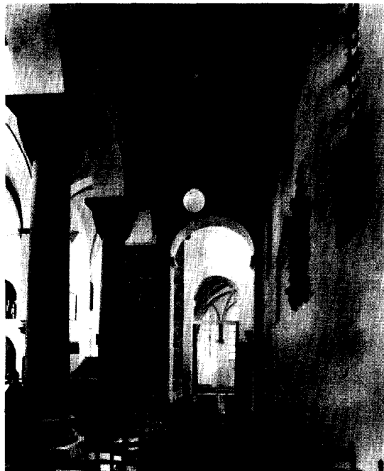
Afb. 22. Foto (na restauratie) vanaf vrijwel hetzelfde punt als waar Pieter Saenredam gestaan heeft. Opvallend is het exact op dezelfde wijze verlopen van de ribben van de gewelven in de Dekenkapel! Voorts ziet men, hoe het flauwe kwartongewelf boven de zijbeuk is vervangen door een reconstructie van het romaanse plafond. (Foto Rijksdienst Monumentenzorg)
