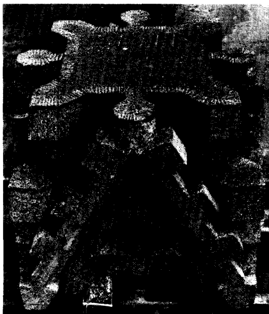
Afb. 12. Met behulp van de werktekening en de mal is het onderste gedeelte van de pinakelhelm in de steenhouwerij gereed gemaakt. Voordat de blokken geplaatst worden hakt de beeldhouwer de ornamentiek. (Foto Rijksdienst voor de Monumentenzorg)
