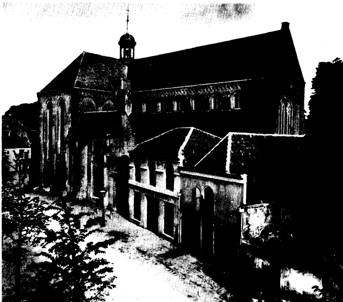
Afb. 2. Aanzicht vanuit het noordwesten, naar ansicht uit ca. 1900. Zichtbaar o.m. het toenmalig noordportaal, de tot consistorie verbouwde Peternellekapel, de houten ramen en het rondboogfries. (Foto Rijksdienst Monumentenzorg)
