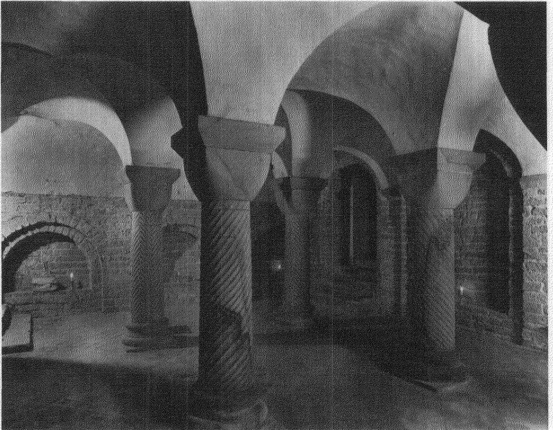
Afb. 16. Crypt naar het westen, na de restauratie. Men ziet de toegangstrappen vanuit de zijkapellen, de lage nissen in de westelijke wand en het contrast tussen de ongepleisterde wanden en de rest van het interieur. (Foto Rijksdienst Monumentenzorg)
