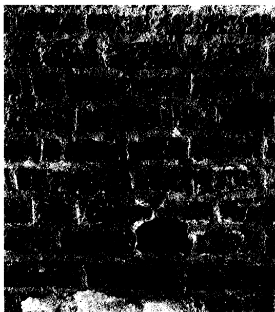
Afb. 47. Fragment van het teruggevonden voegwerk op het oostelijk deel van de zuidelijke zijbeukgevel, in het huidige „Klein-Kapittel”. Door de voegspecie is pangruis gemengd. (Foto Rijksdienst Monumentenzorg)
