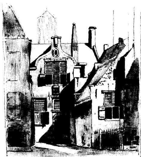
Afb. 55. De zuidelijke aanbouw, zoals deze zich nog in 1836 in zijn 17de-eeuwse toestand vertoonde, vgl. afb. 5 (G.A. Utrecht)
