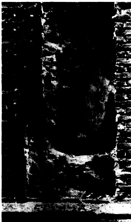
Afb. 54. De aanzet van het gewelf van de galerij tussen de torens, zoals die in het 17de-eeuwse baksteenwerk van de huidige westgevel werd aangetroffen. (Foto Rijksdienst Monumentenzorg)
