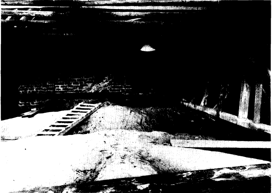
Afb. 23. De gotische sporenkap boven de Dekenkapel, voor restauratie. De daklijn van de romaanse voorganger tekent zich duidelijk af; ook ziet men over de tufsteen uitgestreken rose voegwerk (restant doorgaande bepleistering). (Foto H. N. Bol)
