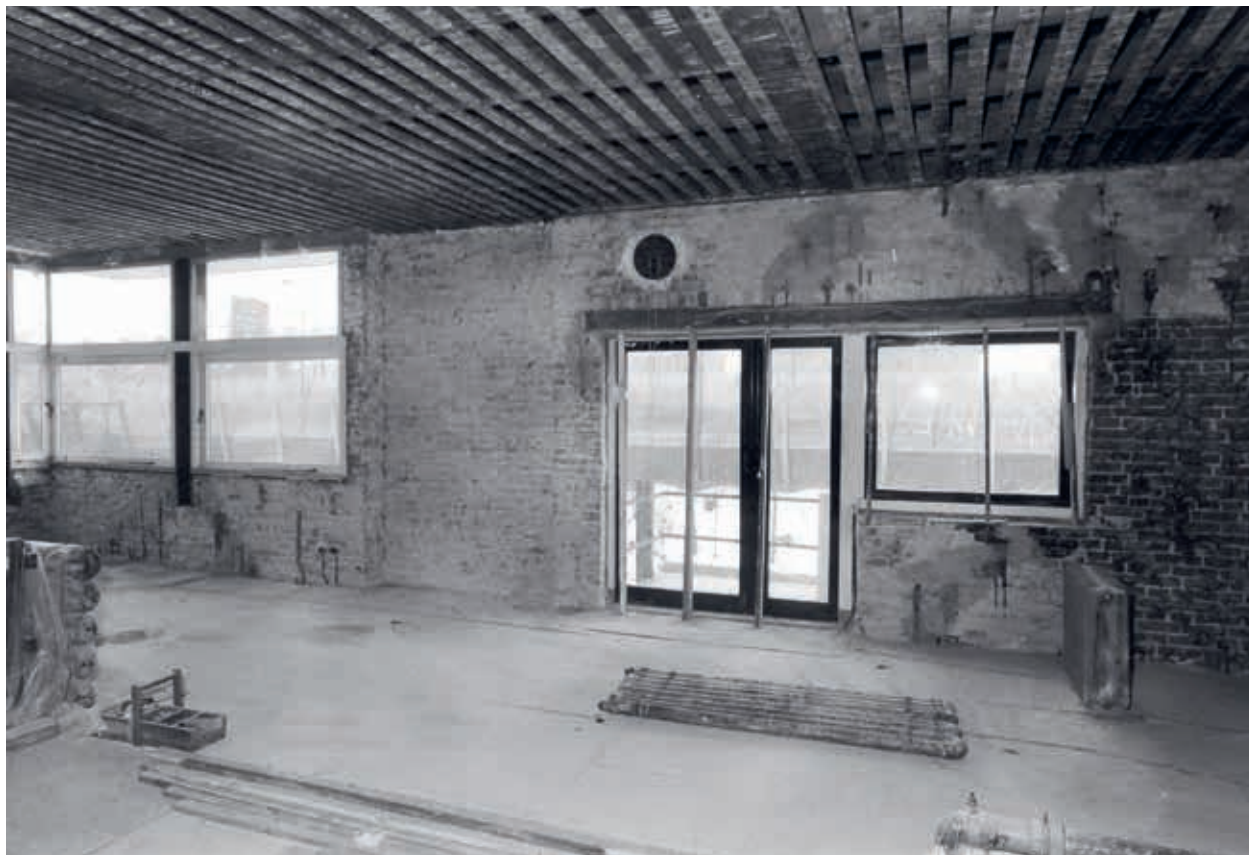
14. Bij de restauratie van de bovenverdieping van het Rietveld Schröderhuis, in 1985-1986, heeft Bertus Mulder wanden en plafond volledig gestript (Bertus Mulder archief)
