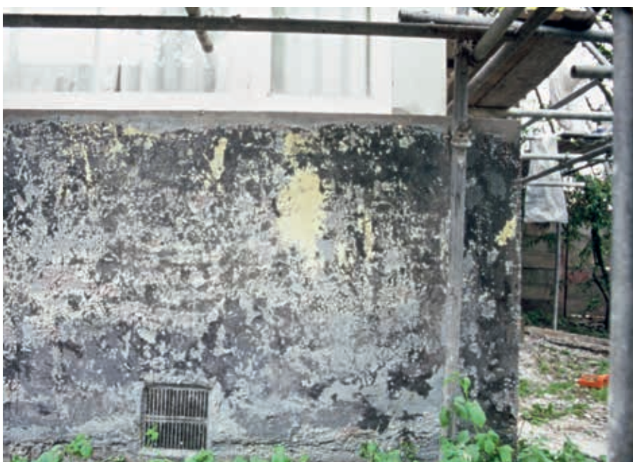
10. Op de borstwering onder het keukenraam kwamen verschillende tinten grijs tevoorschijn. Bertus Mulder heeft het grijs voor dit vlak gebaseerd op het donkergrijs in de rechterbovenhoek (Bertus Mulder archief)
