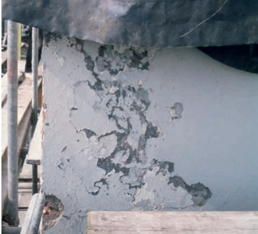
9. Op verschillende plekken, zoals hier op de schoorsteen, trof Bertus Mulder nog diverse resten stuc en afwerklagen aan (Bertus Mulder archief)
