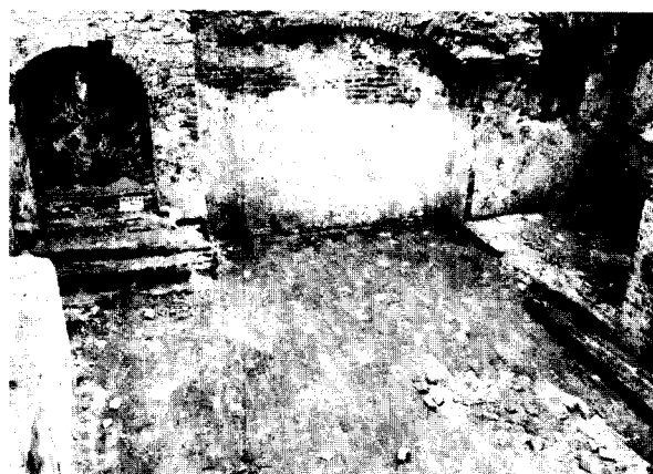
Afb. 3. De kelder van het huis de Hof van Batenburg gezien naar het noordoosten. Links de natuurstenen toog en traptreden van de oorspronkelijke ingang; rechts de bakstenen pijlers voor het secundair aangebrachte gewelf (foto ROB).
