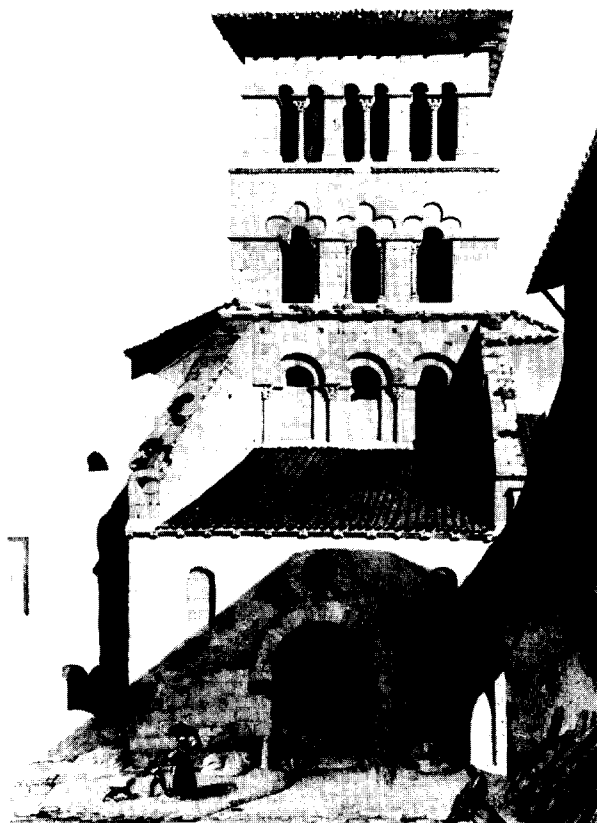
Afb. 5. Ch. Questel, Westgevel van de Saint-Pierre te Vienne in 1844. Het gebouw is in een schilderachtige omgeving met mensfiguren geplaatst. De details zijn echter zeer correct weergegeven (foto Kunsthistorisch Instituut Nijmegen).
