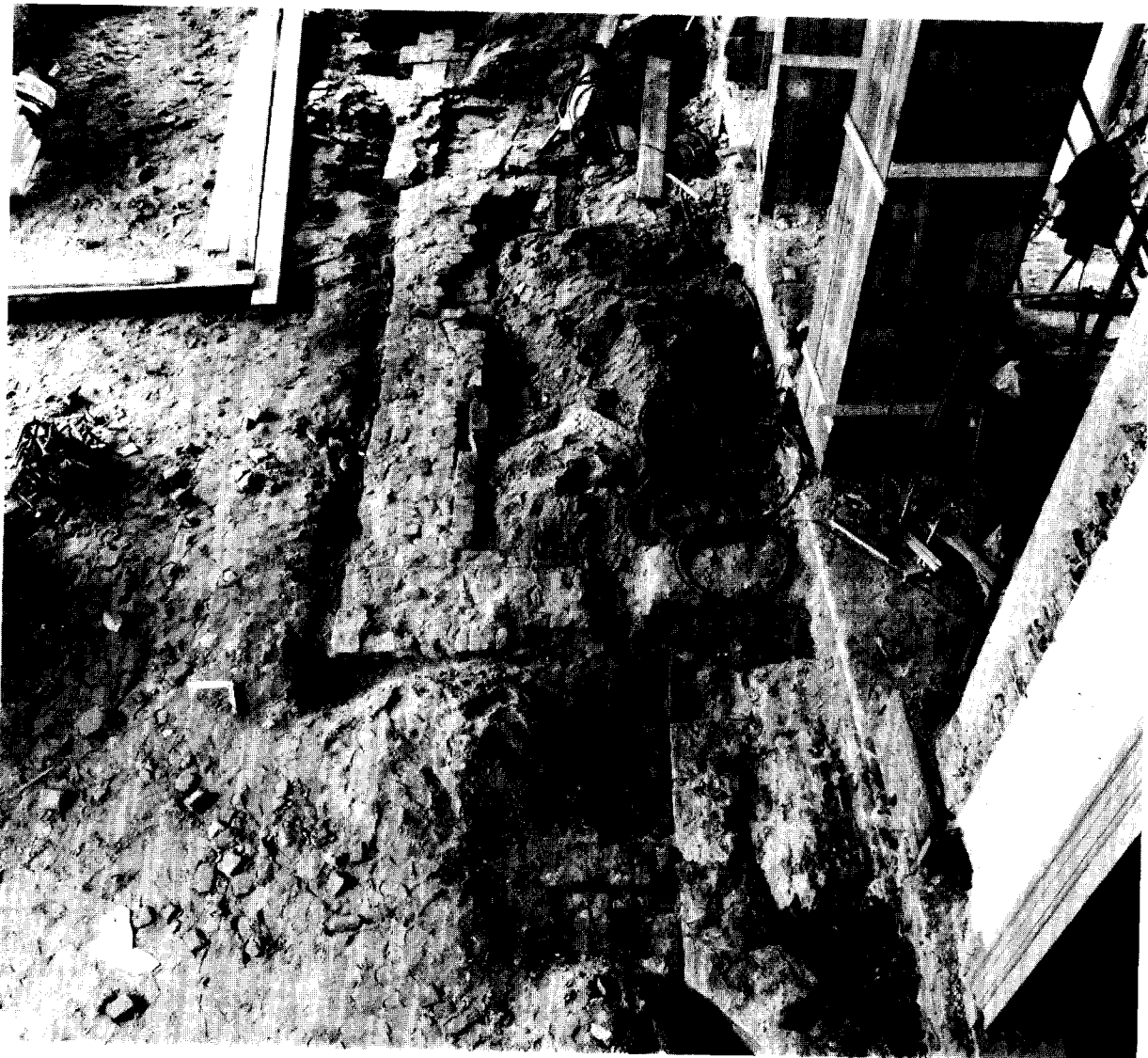
Afb. 7. Muurrestanten van de oostelijke traptoren, het Oude Steen en de tussenvleugel met de oostingang, overzicht naar het zuiden. Rechtsboven de ingepakte zuilen van de tegenwoordige Vierschaar (foto Monumentenzorg, G. J. Dukker 1980).
