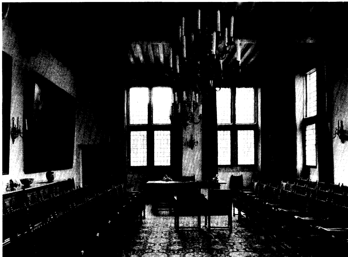
Afb. 30. De nieuwe Trouwzaal op de verdieping, noordwestzijde. Inrichting door Lansdorp 1938-1939, de kruisvensters gereconstrueerd in 1949-1950 en 1962-1966. De consoles in dit vertrek, waarin oorspronkelijk de Wisselbank was gevestigd, zijn authentiek 17e-eeuws (foto Monumentenzorg, G. J. Dukker 1976).
