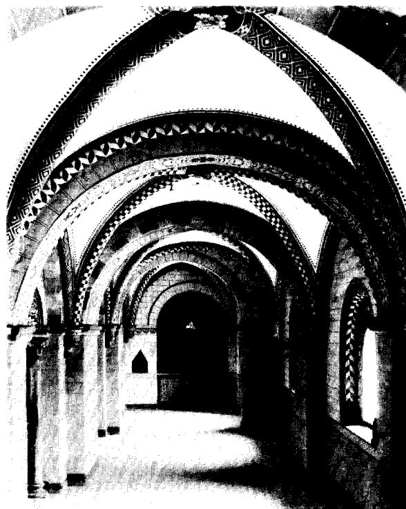
Afb. 31. Het spel der ornamentschilderingen en blokverbanden in de zuidelijk schipgalerij voor de restauratie (foto Monumentenzorg 1914).
