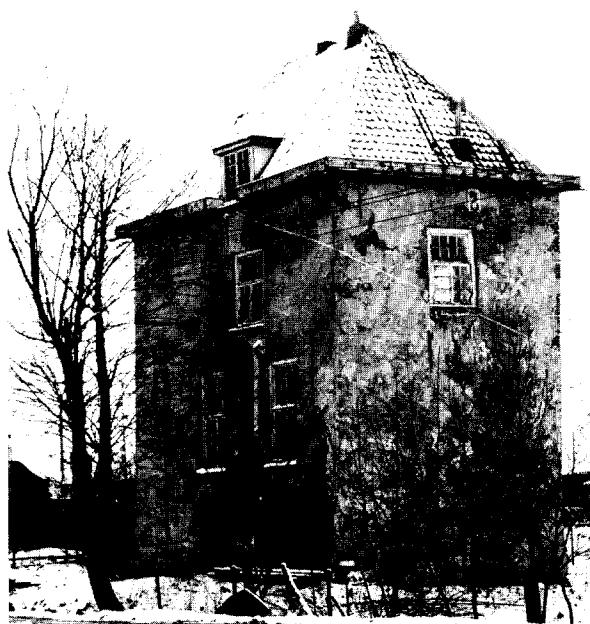
◀ Afb. 5. Het huis Vuylcoop in 1980 (foto auteur).
