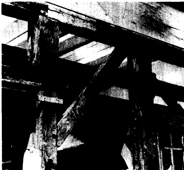
Afb. 15. Het Jan Martense Schenckhuis: gedeelte van de westgevel tijdens de herbouw. Let op de gaten voor de horizontale balkjes voor de zijbeuk op de foto en op de afgezaagde pennen van de ankerbalk (foto Brooklyn Museum).
