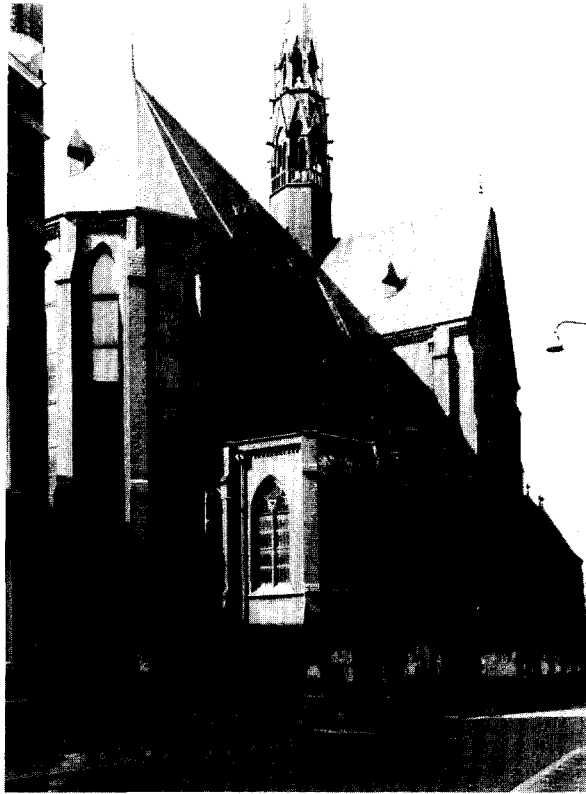
Afb. 3. St.-Martinus, aanzicht vanuit het noordoosten. De bakstenen balustrade om het dak van het zijkoor werd in de jaren 60 afgebroken (foto Centrale Fotodienst (CFD), Groningen, 1971).
