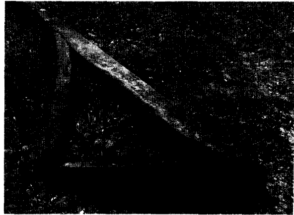
Afb. 3. Detail van gespan; spoor, standzoon en blokkeel (foto H. Scholten, RDMZ).
