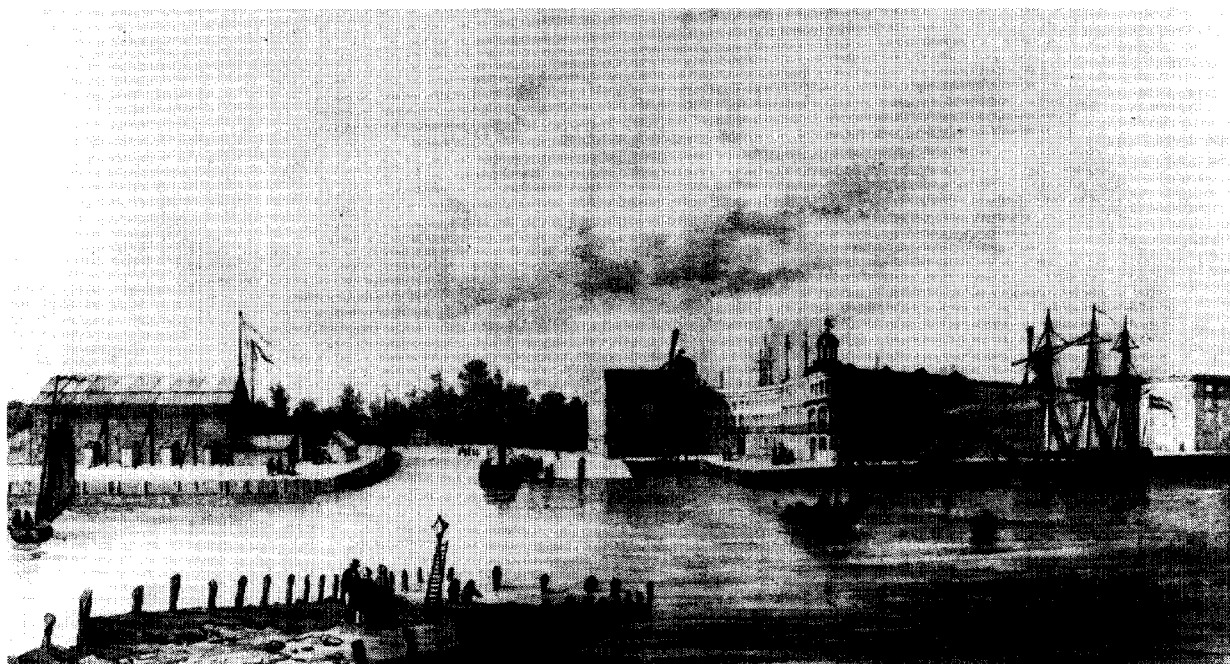
Afb. 4. 'Gezigt op het Nieuwe Werk met het Feestgebouw', litho door A. C. Nunnink naar M. Maris, uit Rotterdam in MDCCCL IV. Een Gedenkboek en eene Kunstkroniek. Te 's-Gravenhage bij K. Fuhri, 1855. Het feestgebouw, links op de afbeelding, was voor de viering van het 25-jarig bestaan van de Mij. tot bevordering der toonkunst (G.A. Rotterdam).
