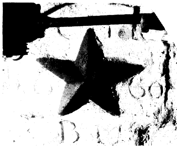
Afb. 7. De sluitsteen van een van de keldergewelven van het stadhuis met het opschrift (in spiegelschrift) CP 1660 BM (foto J. M. Matthijsen).
