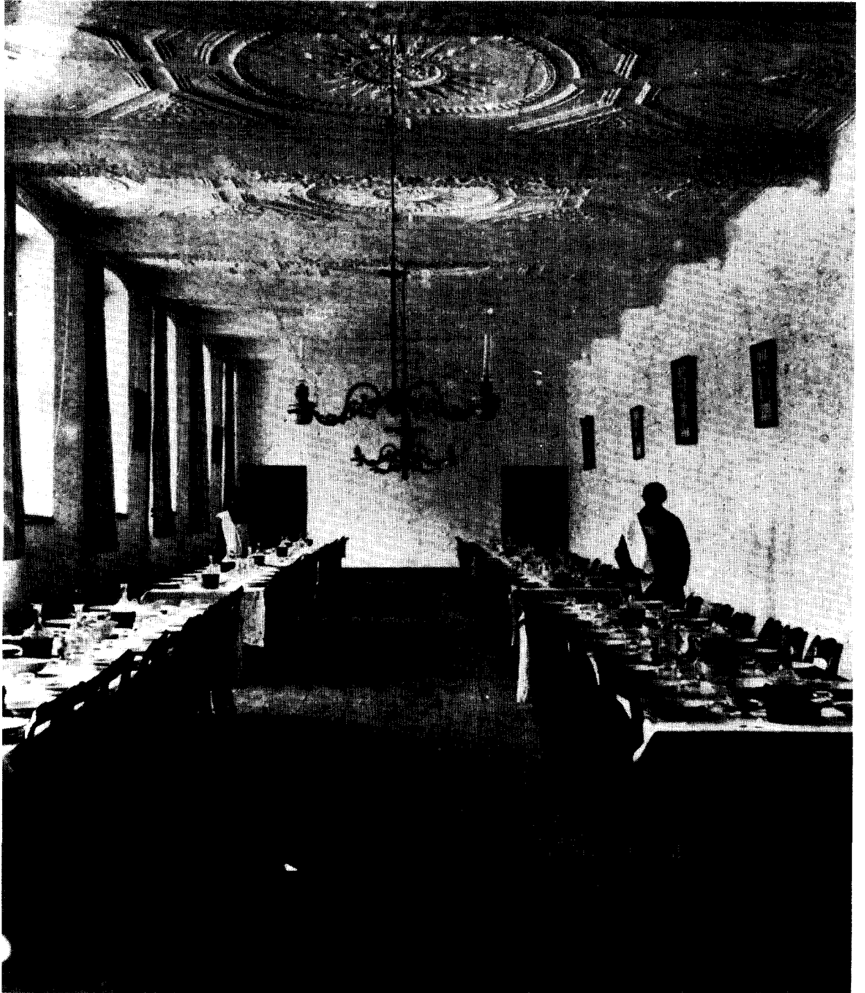
Afb. 8. Het interieur van de refectorie in de noordvleugel vóór de verbouwing van 1892. Blick in oostelijke richting. De laat-17e-eeuwse stucdecoraties op het balkenplafond zijn thans niet meer aanwezig (foto Archief Ned. Prov. Jezuïeten, Nijmegen).
