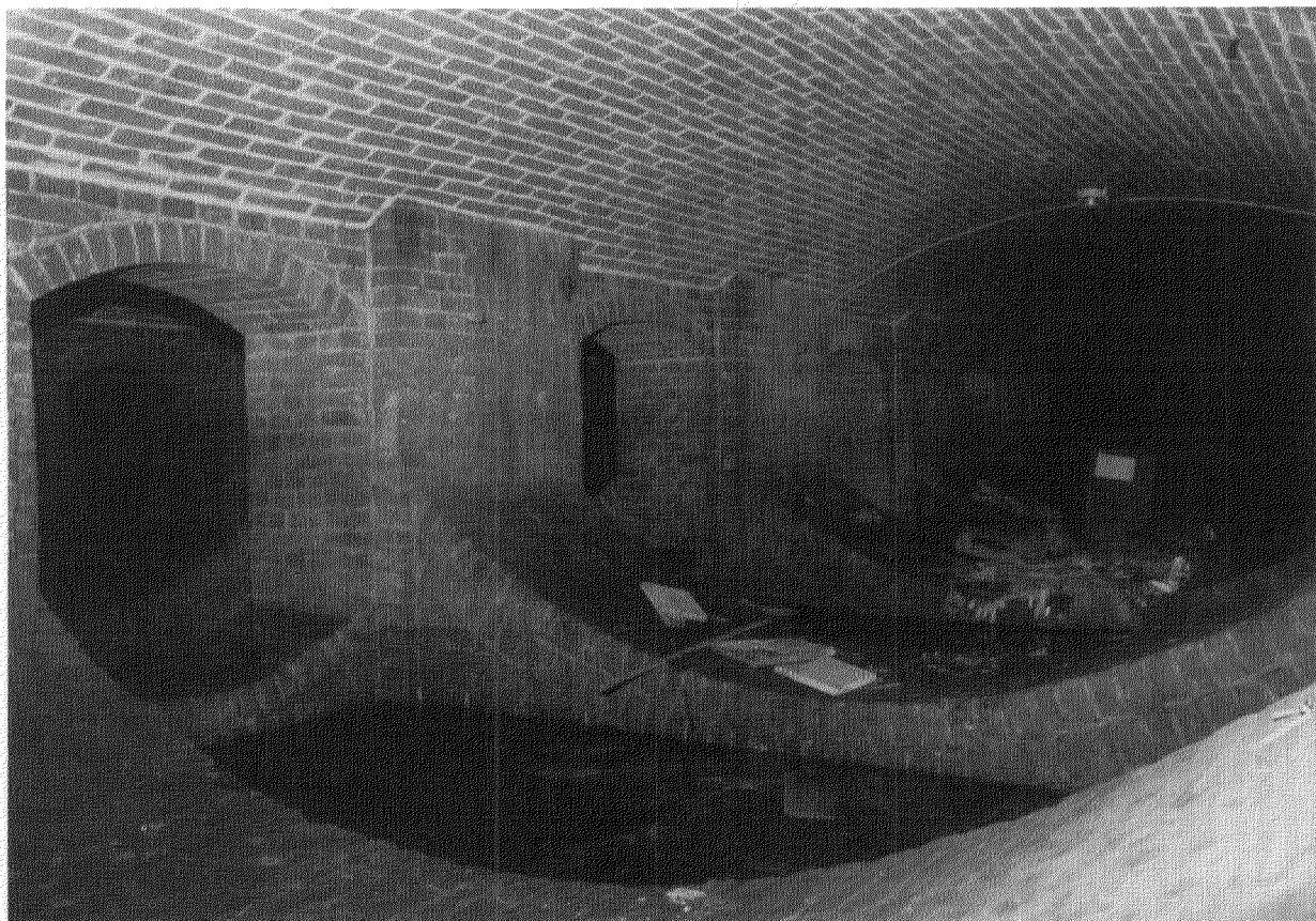
Afb. 3. Spel van bogen en contrabogen in de kelder van het depot van het Rijksarchief (foto W. van Leeuwen, 1986).
