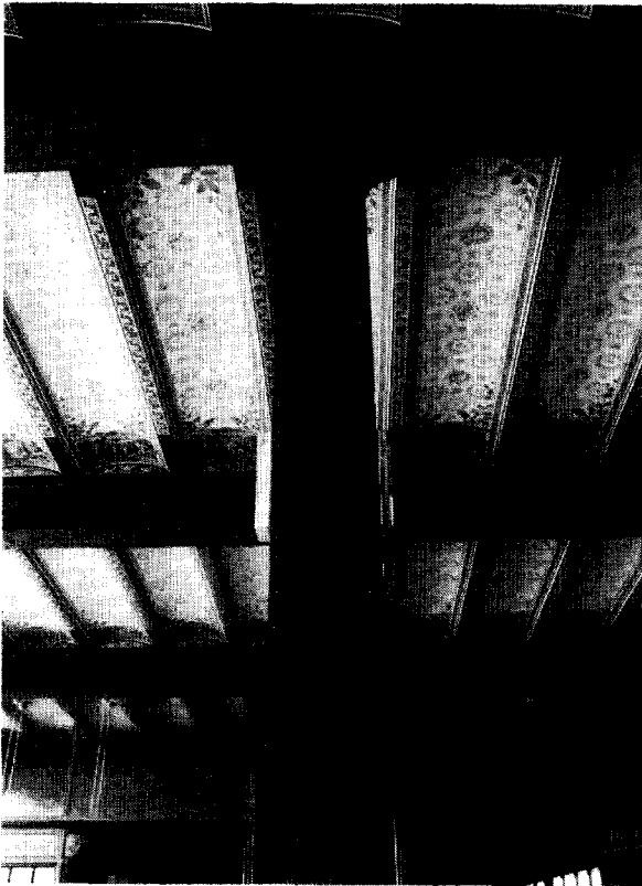
Afb. 6. Het plafond van de leeszaal met heldere sjabloon-schilderingen en decoratief schilderwerk op de ijzeren kolommen en binten (foto W. van Leeuwen, 1986).
